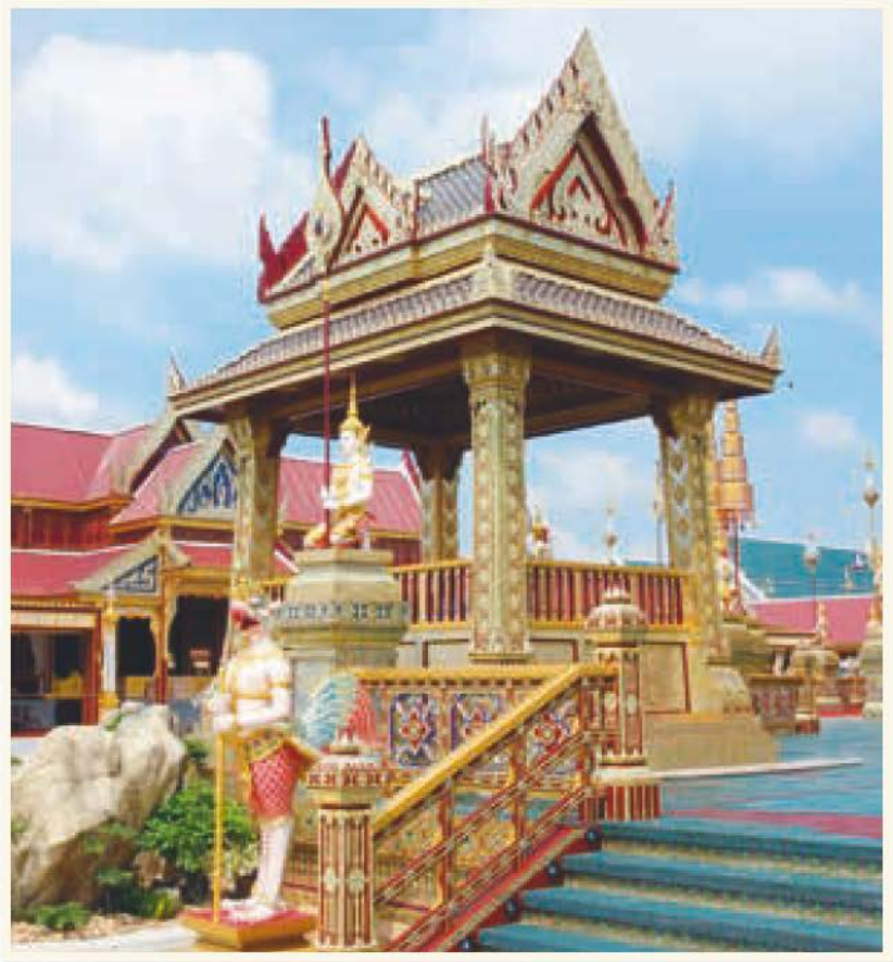
ช่างในบริเวณพระเมรุ งานพระราชพิธีพระราชทานเพลิงพระศพ สมเด็จพระเจ้าพี่นางเธอ เจ้าฟ้ากัลยาณิวัฒนา กรมหลวงนราธิวาสราชนครินทร์
