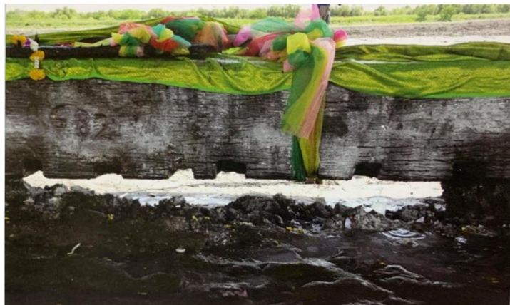
ภาพที่ 5 ไม้ทับกระดุง ด้านล่างของไม้ มีการบากเป็นร่องสี่เหลี่ยมสลับกัน
