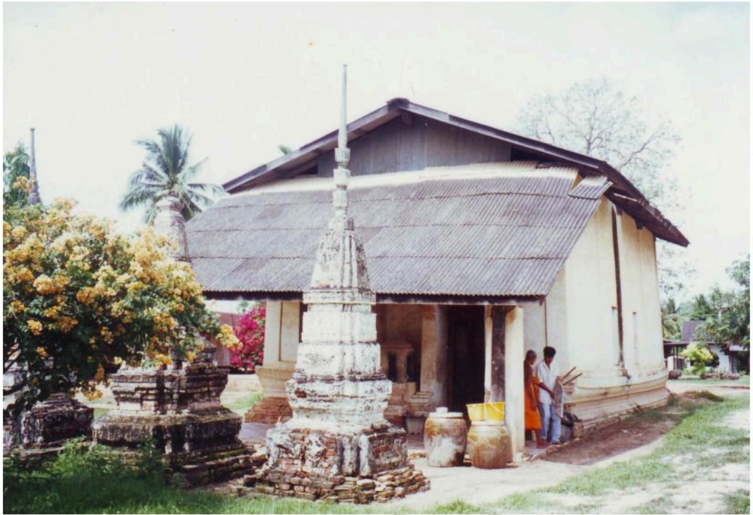
อุโบสถ วัดจันทาราม ทางวัดได้รื้อหลังคาลง แล้วทำหลังคาสังกะสีคลุมไว้ด้านหน้ามีเจดีย์รายหลายองค์
