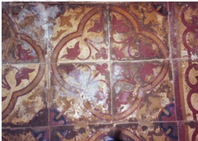
กระเบื้องปูพื้นอุโบสถวัดห้วยหลวง แยกเป็นแผ่นนำประกอบเป็นลวดลาย
