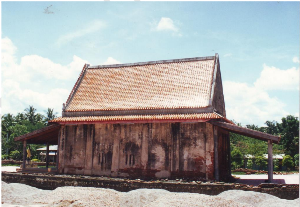
ผนังพระอุโบสถก่ออิฐถือปูน เจาะช่องแสงขนาดเล็ก
