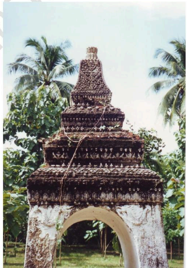
ซุ้มประตู ประดับด้วยลวดลายปูนปั้น ด้านล่างเป็นรูปมังกร
