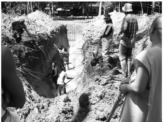
ขณะกำลังแต่งผนังดินหลุมขุดตรวจ
