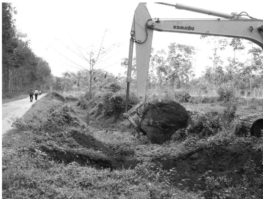
เริ่มดำเนินการขุดตรวจ
