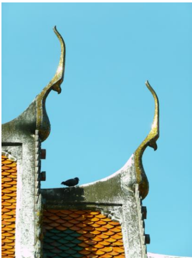
ช่อฟ้าสกุลช่างวังหลวง นิยมทำแบบปากครุฑ คือ ทำจอยปากจุ่มลง
