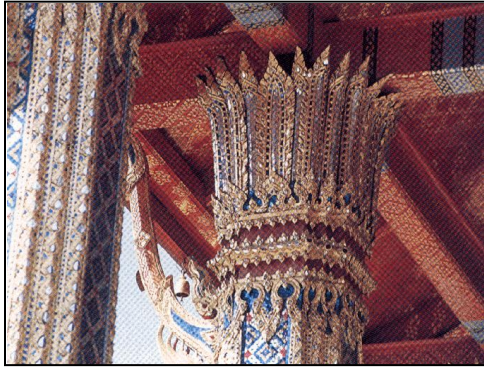
เสาพระอุโบสถวัดพระศรีรัตนมหาธาตุ เป็น เสาเครื่องก่อ ย่อมุมไม้สิบสอง บัวหัวเสา แบบบัววงกล
