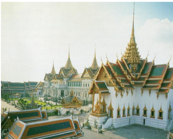
สถาปัตยกรรมสกุลช่างวังหลวง หลังคาทรงปราสาท มุขลดซ้อนหลายชั้น นิยมมุงกระเบื้องเคลือบสี
