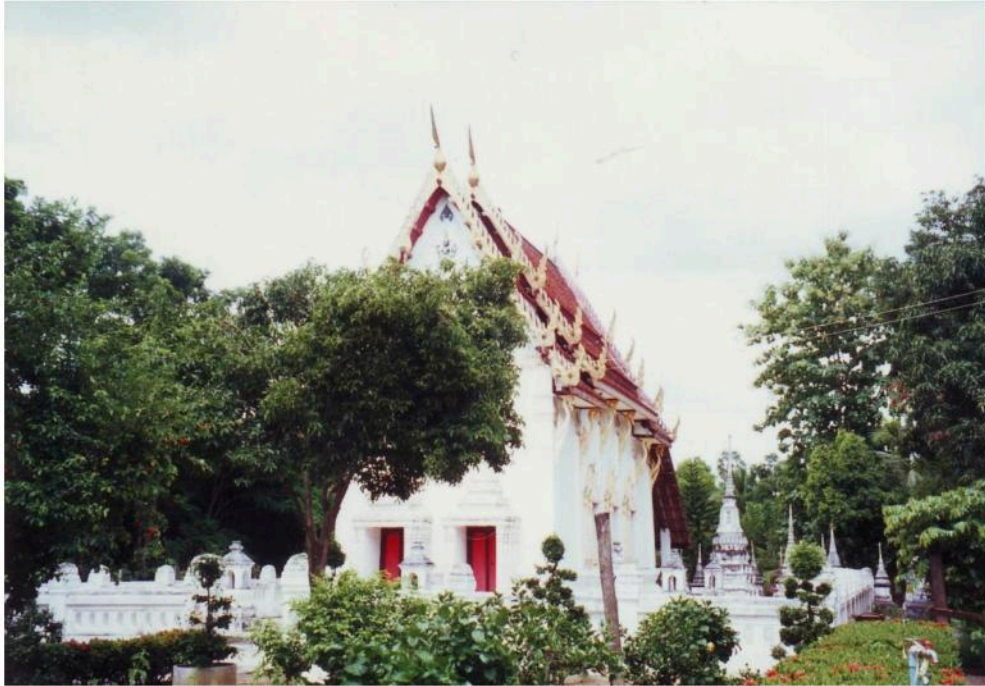
อุโบสถวัดท่าศาลา ทางวัดบูรณะแล้วแต่ยังคงรูปทรงเดิมไว้
