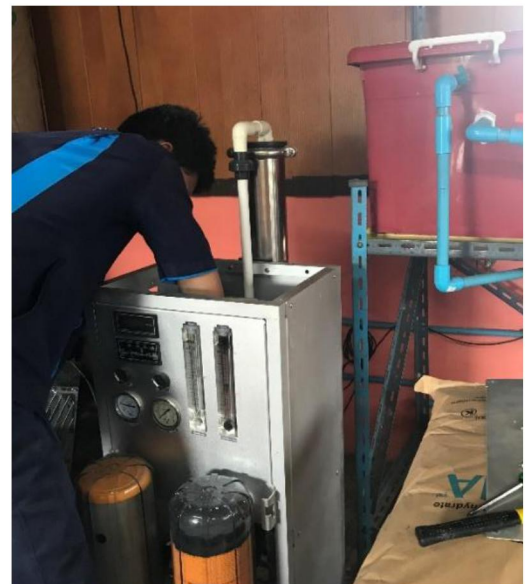
ภาพที่ 3-16-การซ่อมบำรุงเครื่องกรองน้ำขนาดใหญ่
