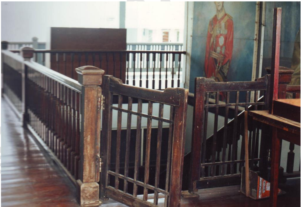
บันไดไม้ขนาดใหญ่เชื่อมต่อกับชั้นบน
