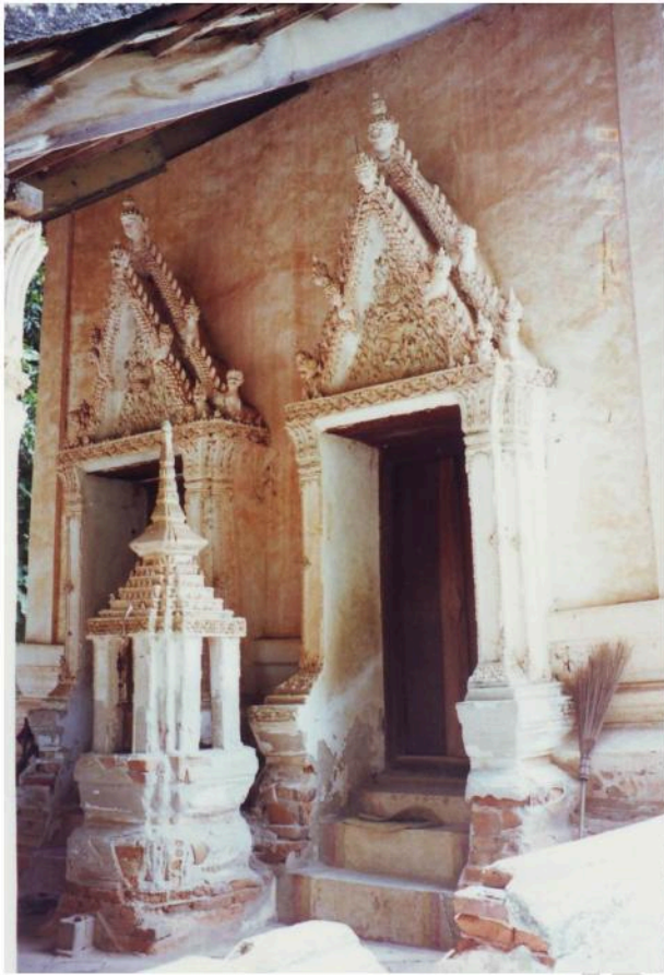
ซุ้มประตูอุโบสถวัดดอนกอก เป็นซุ้มบันแถลง ตกแต่งด้วยลวดลายปูนปั้น ด้านหน้าอุโบสถมีซุ้มเสมาประธาน ย่อมุมไม้สิบสอง ยอดทรงมณฑป
