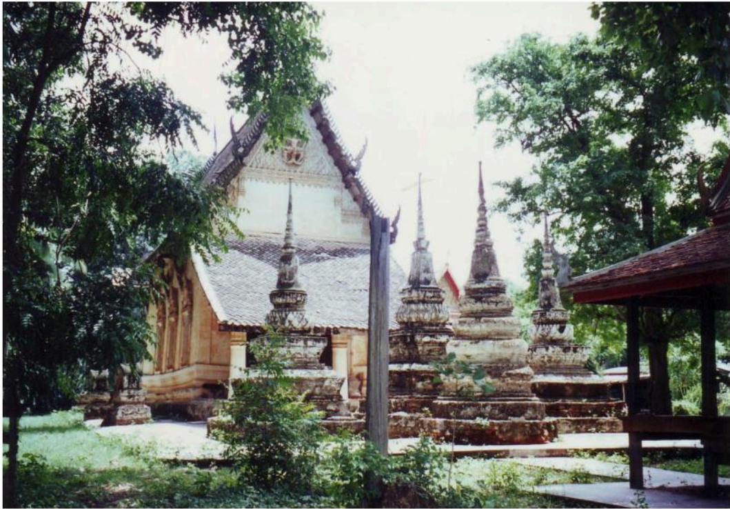
อุโบสถวัดดอนกอก ด้านหน้ามีเจดีย์ฐานย่อมุมไม้สิบสอง และเจดีย์ทรงกลม
