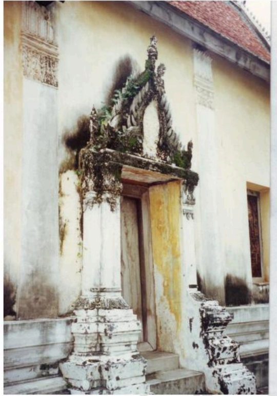
ซุ้มประตูด้านข้าง (ทางทิศเหนือ) อุโบสถเป็นแบบ ซุ้มบันแถลง ประดับลวดลายปูนปั้น
