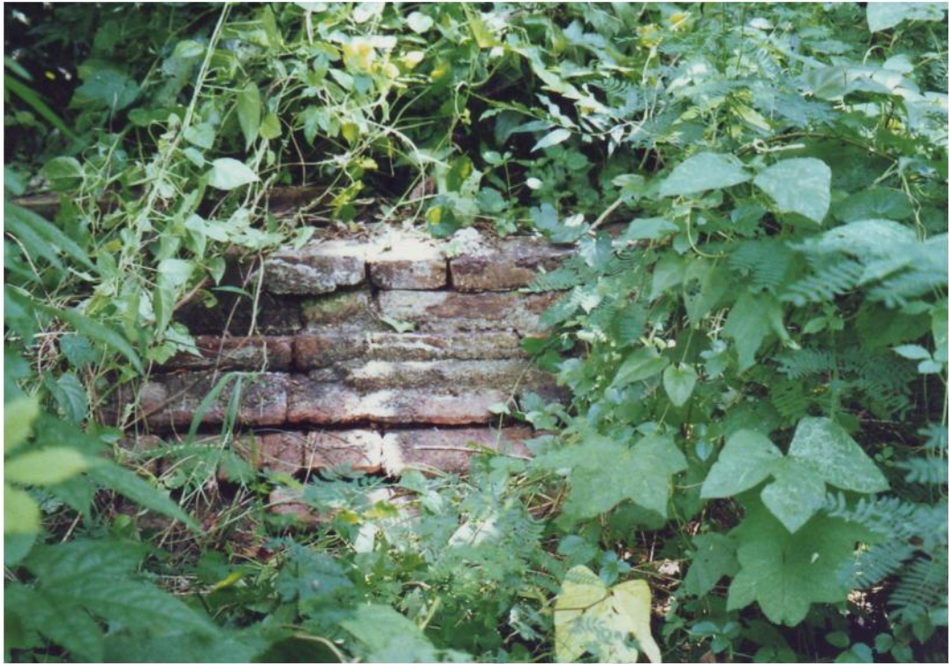
แนวฐานสิ่งก่อสร้าง (อุโบสถ) วัดเหนือ (ร้าง) ทางด้านทิศเหนือเห็นเทคนิคการก่อผนังอิฐขัดเจน
