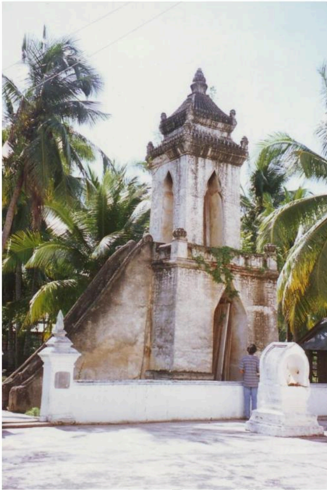
หอรระซัง วัดโพธิ์กรู เป็นอาคารแบบประยุกต์ ส่วนยอดคล้ายกังหัน ตัวอาคารเจาะซุ้มยอด- แหลม
