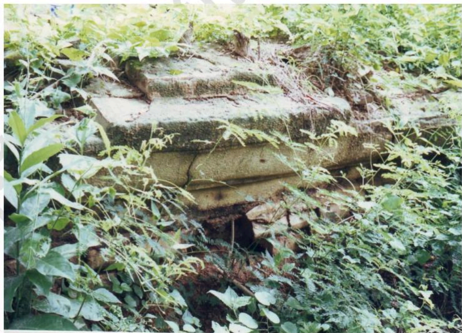
ฐานอุโบสถวัดวิหารเปลี่ยว ก่ออิฐฉาบปูน ตกแต่งเป็นฐานบัว
