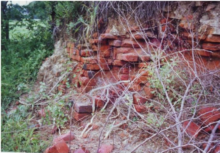
ฐานของโบราณสถาน บางส่วนยังเหลือหลักฐาน ให้เห็นเทคนิคการก่อเรียงอิฐ
