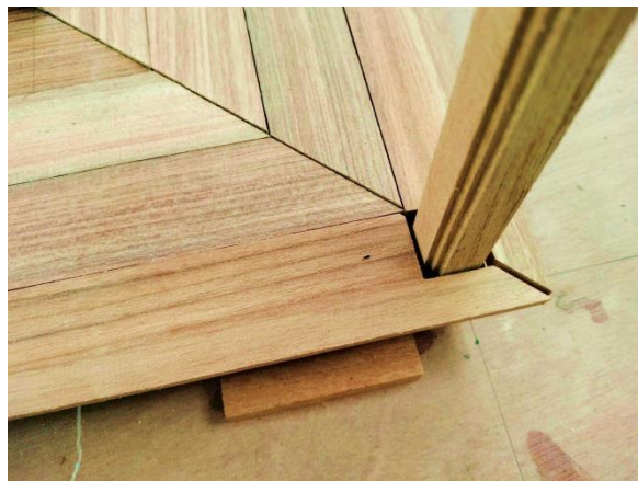
ลักษณะการปูไม้พื้นกระดานและการเข้ามุมช่วงเสา
