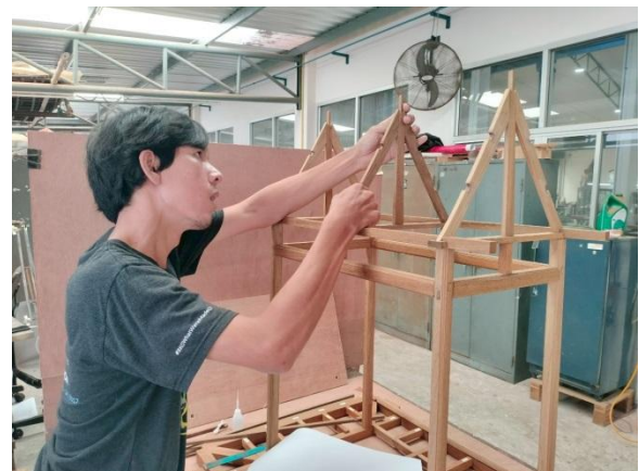
ประกอบโครงสร้างไม้ ใบดิ่งจันทันลงบนแปและซื่อรับหัวเสา
