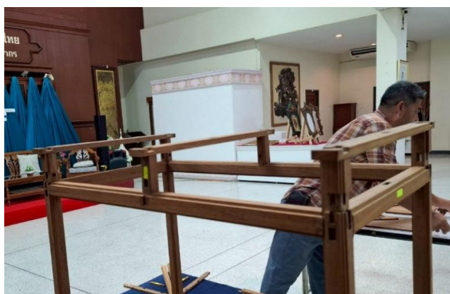
ประกอบขื่อเข้ากับหัวเสาเพื่อเตรียมติดตั้งประกอบแปหัวเสา
