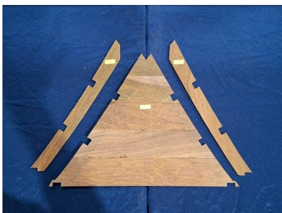
แผ่นไม้กระดานรองรับลายหน้าบันและไม้ยกขอบจันทัน (หน้าและ
