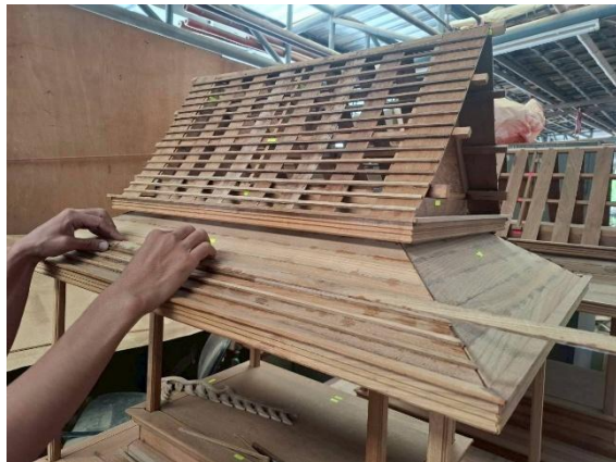
การติดตั้งไม้ระแนงชั้นหลังคา
