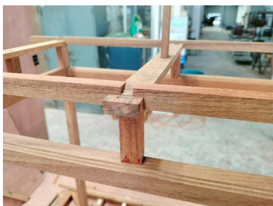
ประกอบแปรับหัวเสาเข้ากับซื่อ ด้านซ้ายและขวา
