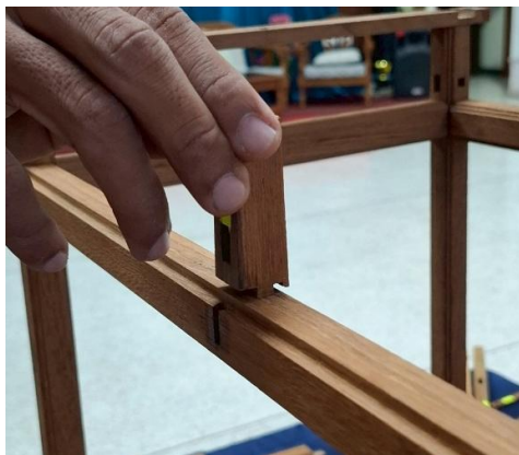
ประกอบขื่อเข้ากับหัวเสาเพื่อเตรียมติดตั้งประกอบแปหัวเสา
