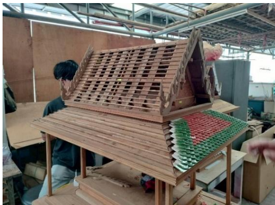
ขั้นตอนการปูกระเบื้องหลังคา
