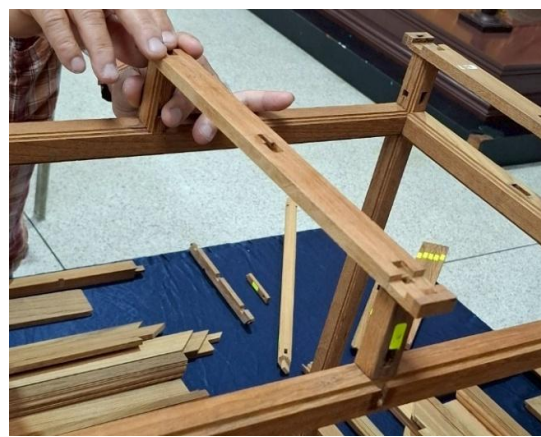
โครงสร้างขื่อสำหรับบังคับหัวเสา (โถงประธาน)
