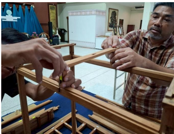
โครงสร้างขื่อสำหรับบังคับหัวเสา (โถงประธาน)
