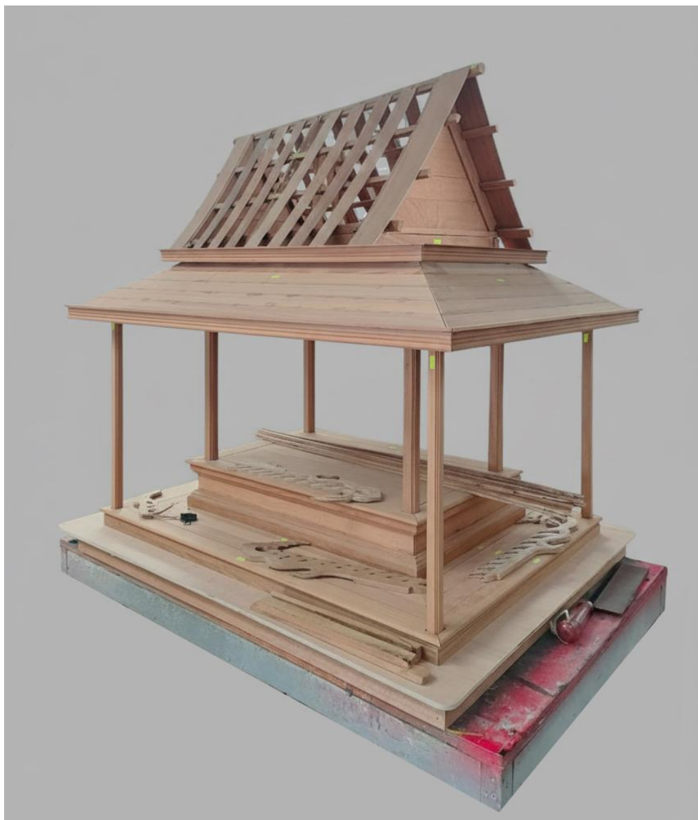
โครงสร้างพระที่นั่งปาฏิหาริย์ทัศไนย (จำลอง) ประกอบชั้นฐาน ตัวเรือนและโครงสร้างหลังคาแล้วเสร็จ
