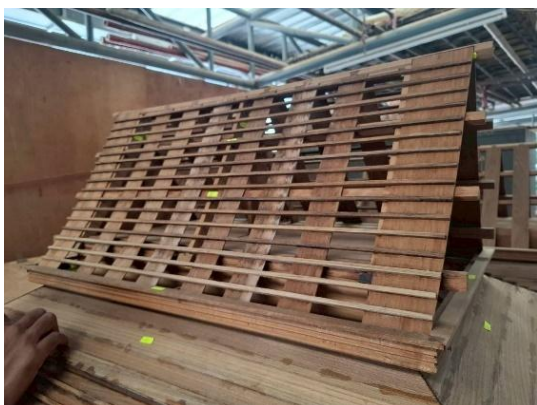
ภาพแสดงการวางไม้ระแนงสำหรับการปูกระเบื้องหลังคา
