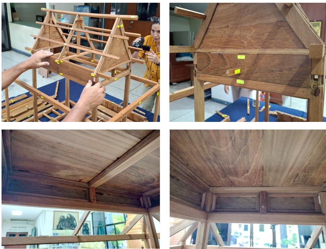
การประกอบโครงสร้างแผงลูกฟักกระดานคูน
