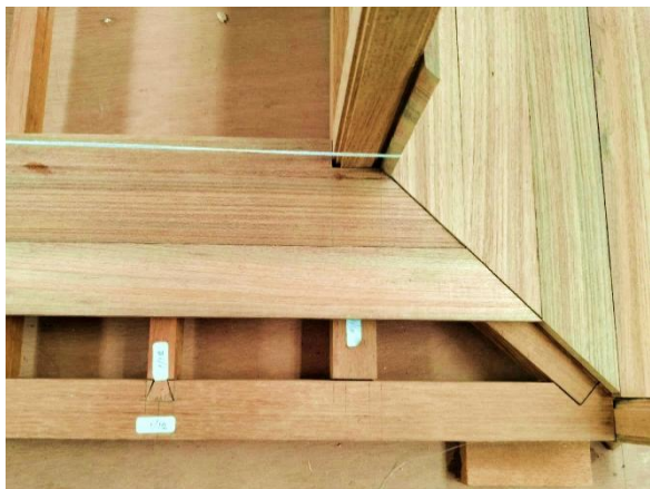
ลักษณะการปูไม้พื้นกระดานและการเข้ามุมช่วงเสา
