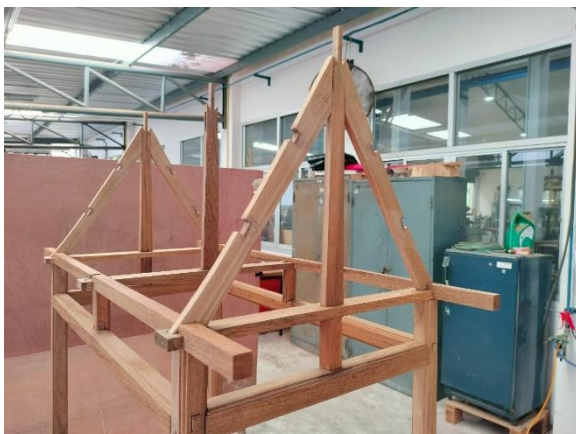
ประกอบโครงสร้างไม้ ใบดิ่งจันทันลงบนแปและซื่อรับหัวเสา
