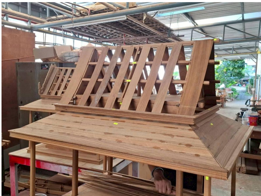
การประกอบติดตั้งฝ้าโครงส่วนหลังคาและชั้นเชิงชาย
