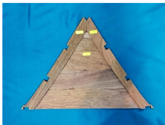
แผ่นไม้กระดานรองรับลายหน้าบันและไม้ยกขอบจันทัน (หน้าและ
