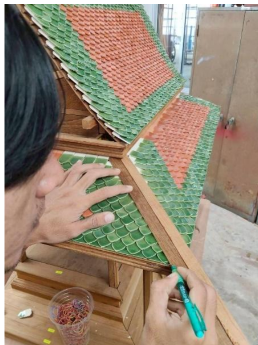
ขั้นตอนการประกอบสันตะเข้เชื่อมปิดมุมหลังคา
