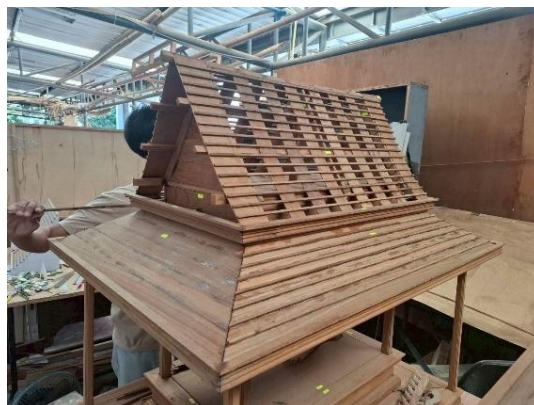
ภาพแสดงการวางไม้ระแนงสำหรับการปูกระเบื้องหลังคา
