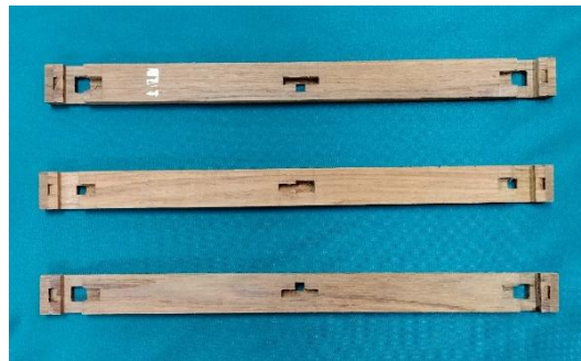
โครงสร้างขื่อสำหรับบังคับหัวเสา (โถงประธาน)
