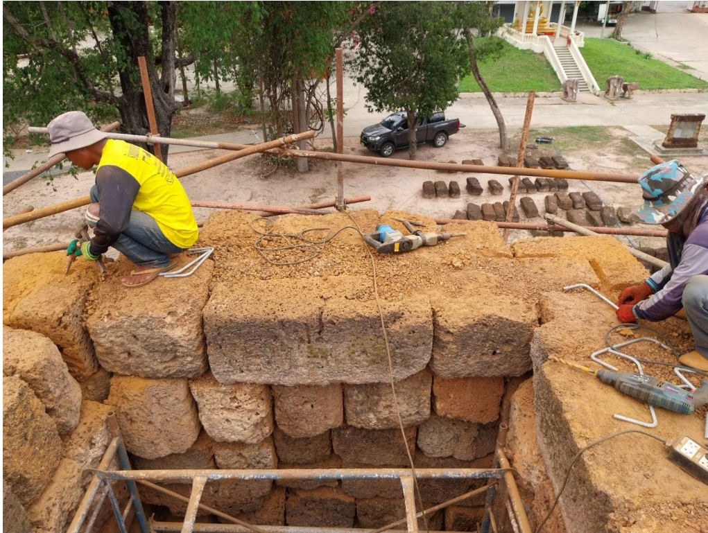
ภาพที่ ๓.๑๖ ยึดหินก้อนมุมด้วยเหล็กชุบป้องกันสนิม
