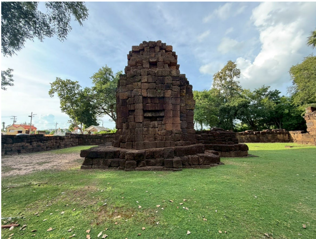
ภาพที่ ๔.๓ สภาพปัจจุบันปราสาทประธานด้านทิศใต้
