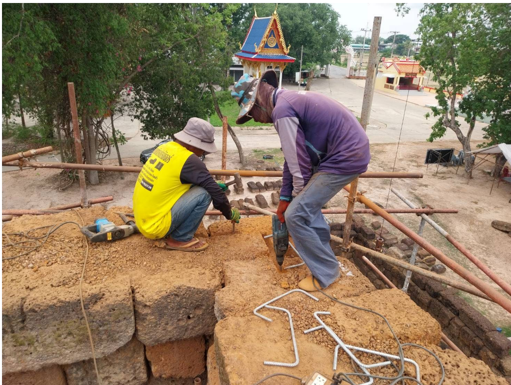
ภาพที่ ๓.๑๙ ยึดหินก้อนมุมด้วยเหล็กชุบป้องกันสนิม
