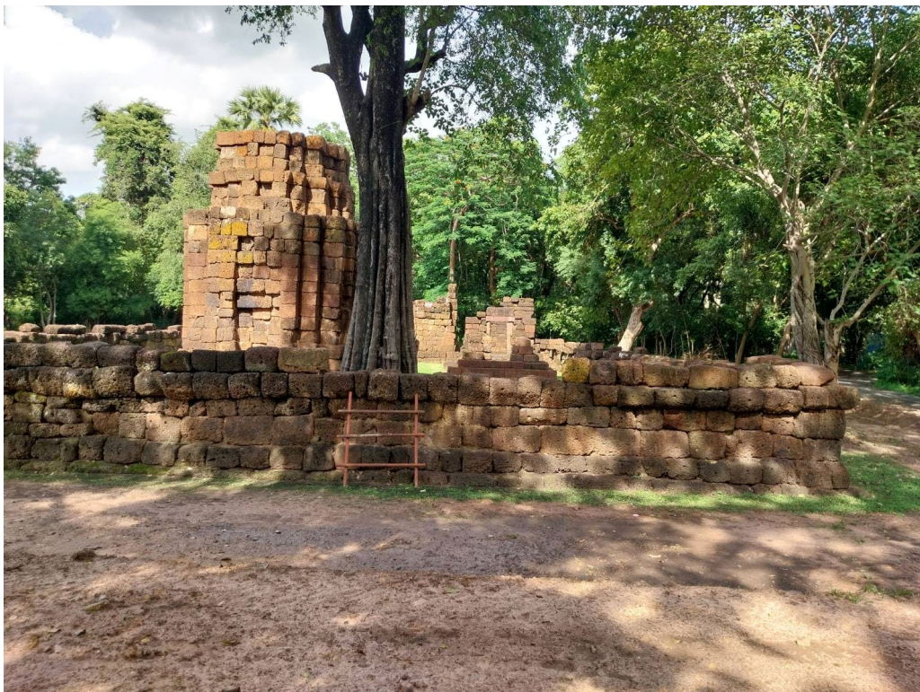
ภาพที่ ๓.๖๘ รูปด้านทิศตะวันตก หลังการดำเนินงานแล้วเสร็จ
