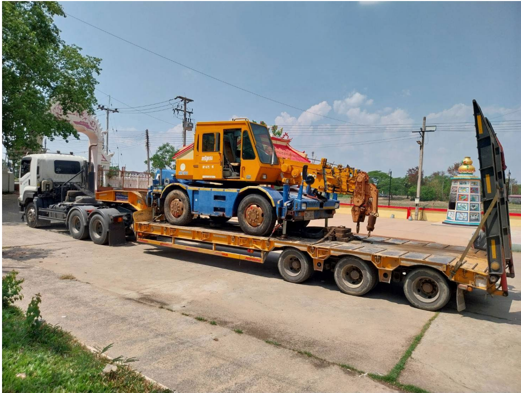
ภาพที่ ๓.๕ ขนย้ายรถเครนสำหรับเคลื่อนย้ายและทดลองประกอบศิลาแลงเข้าพื้นที่ดำเนินงาน
