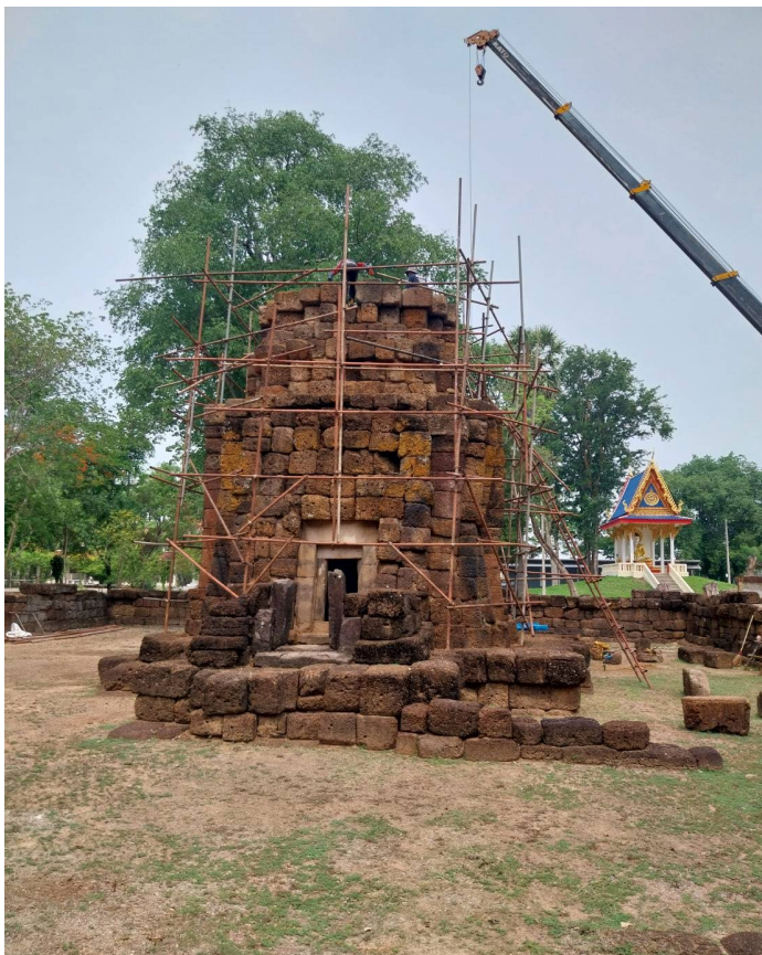
ภาพที่ ๓.๔๑ ดำเนินงานประกอบหินทดลองประกอบและเสริมหินที่เหลือจากการทดลองประกอบแล้วเสร็จ
