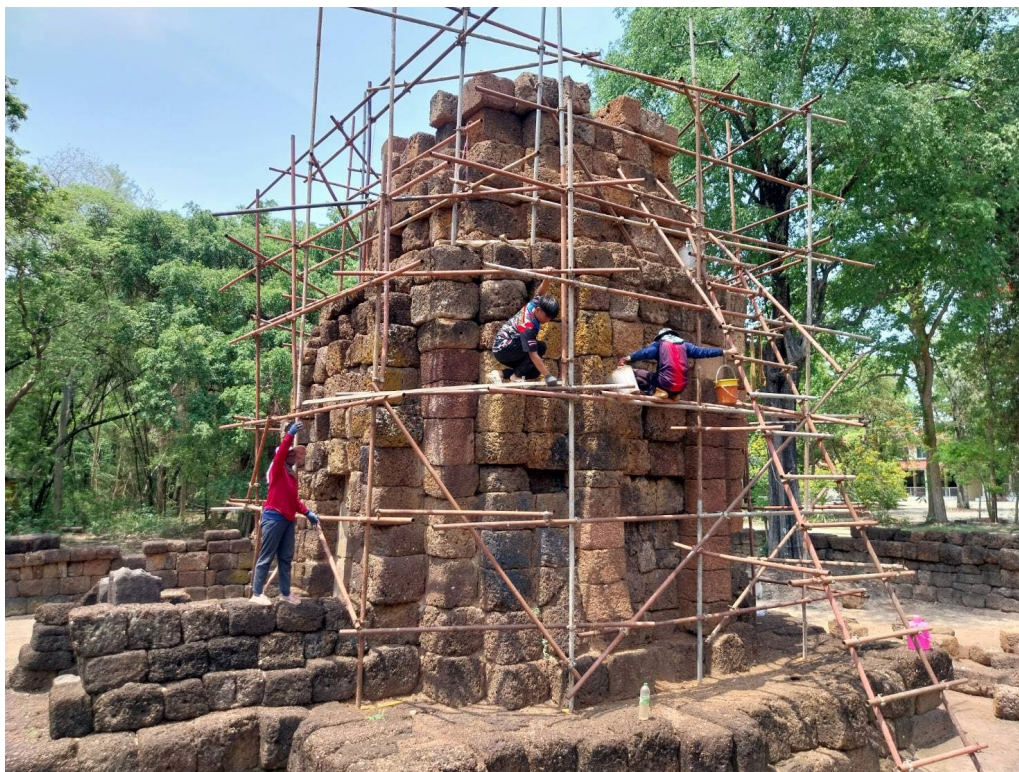
ภาพที่ ๓.๒๘ เสริมหินที่เหลือจากการทดลองประกอบชั้นสุดท้ายของชั้นวิมานชั้นที่ ๒
