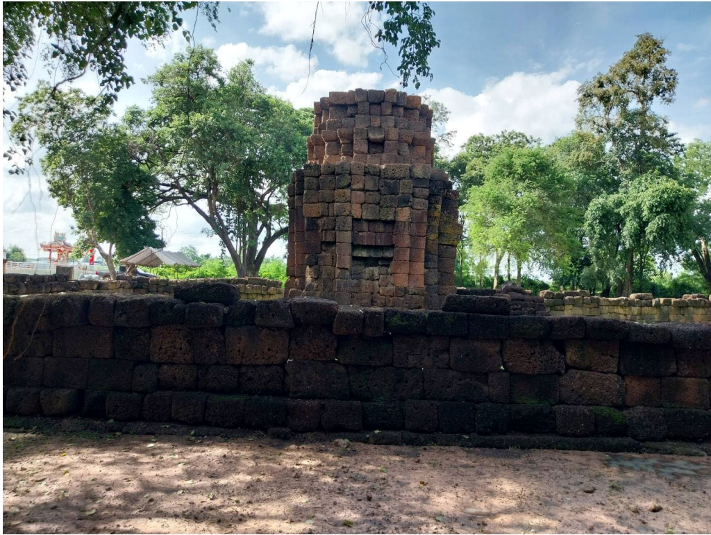
ภาพที่ ๓.๖๗ รูปด้านทิศใต้ หลังการดำเนินงานแล้วเสร็จ
