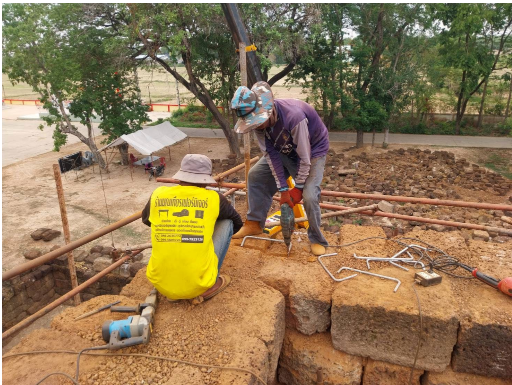
ภาพที่ ๓.๒๑ ยึดหินก้อนมุมด้วยเหล็กชุบป้องกันสนิม
