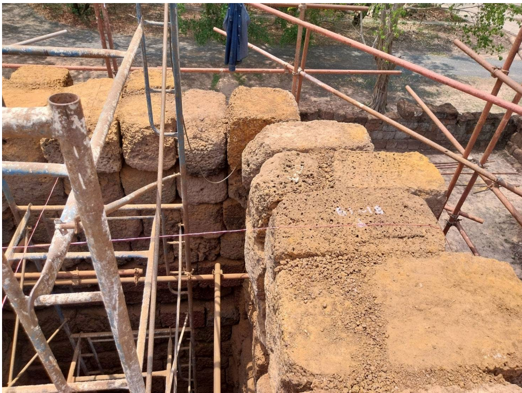
ภาพที่ ๓.๒๓ สกัดปรับแต่งหลังหินที่เหลือจากการทดลองประกอบก่อนเรียงชั้นวิมานชั้นที่ ๒
