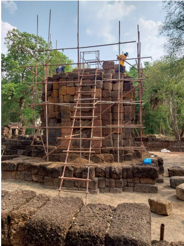
ภาพที่ ๓.๑๓ ดำเนินงานประกอบชิ้นส่วนหิน ทดลองประกอบตามผังและร่องรอยบ่หินชั้น
