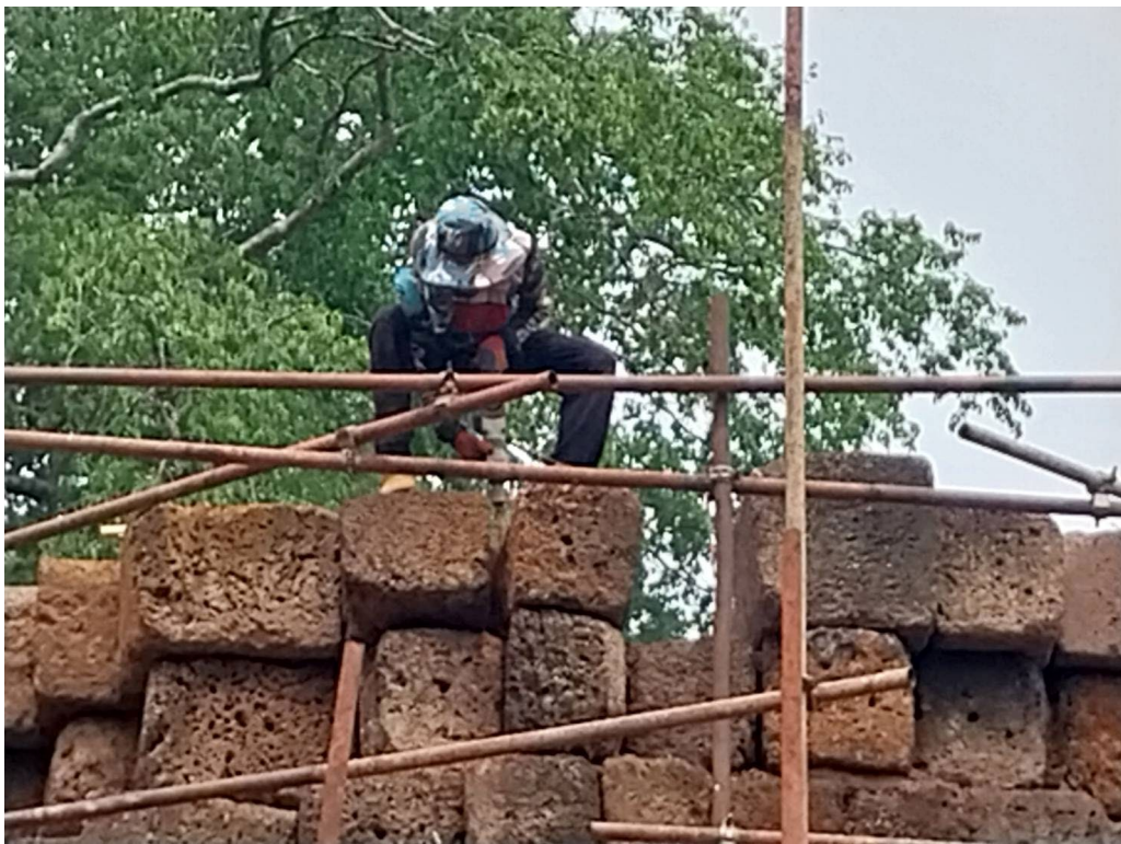
ภาพที่ ๓.๓๓ เสริมหินที่เหลือจากการทดลองประกอบชั้นสุดท้ายของชั้นวิมานชั้นที่ ๒
