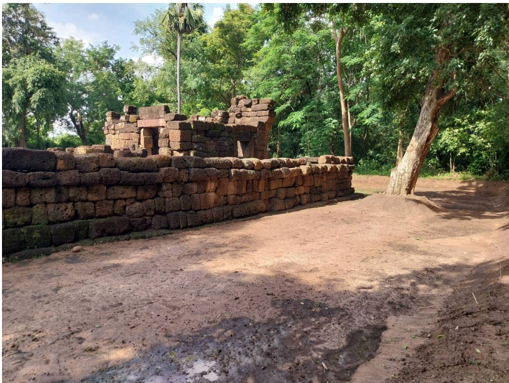
ภาพที่ ๓.๖๔ รูปด้านทิศใต้ หลังการดำเนินงานแล้วเสร็จ
