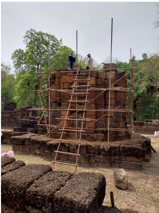
ภาพที่ ๓.๑๒ ดำเนินงานเสริมหินที่เหลือจาก การทดลองประกอบชั้นวิมานของปราสาท ประธาน
