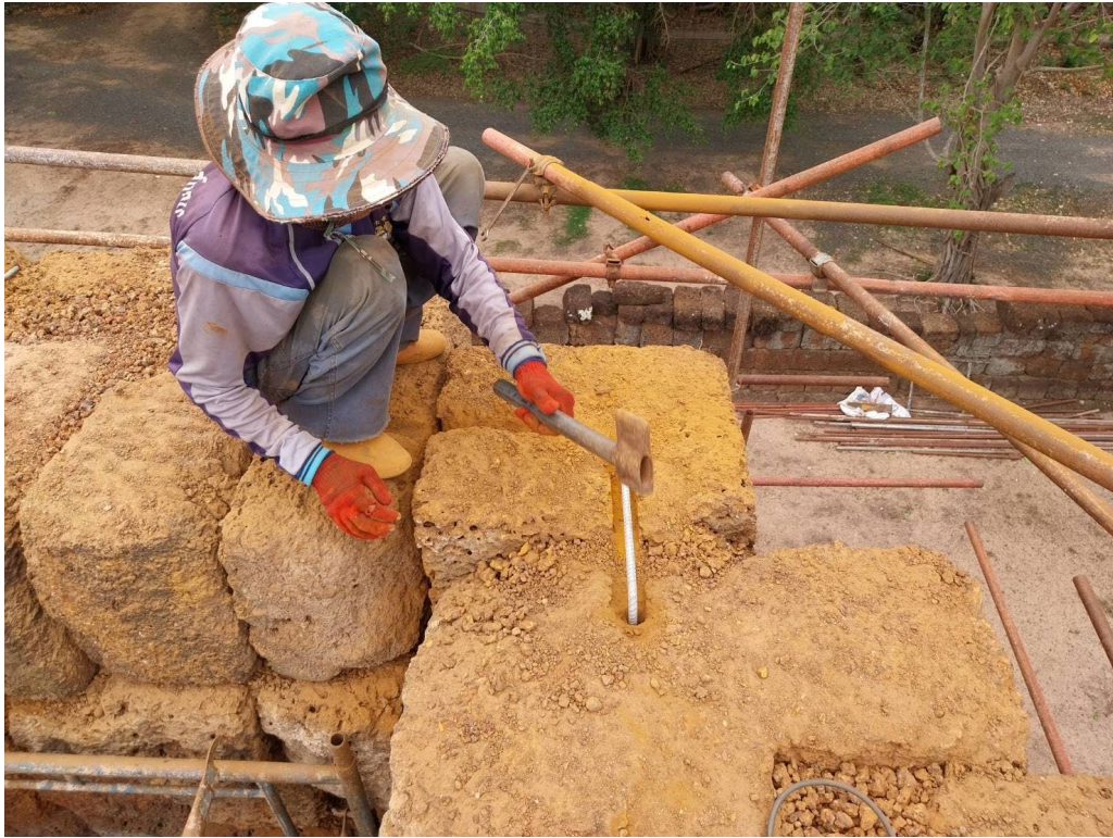
ภาพที่ ๓.๒๐ ยึดหินก้อนมุมด้วยเหล็กชุบป้องกันสนิม
