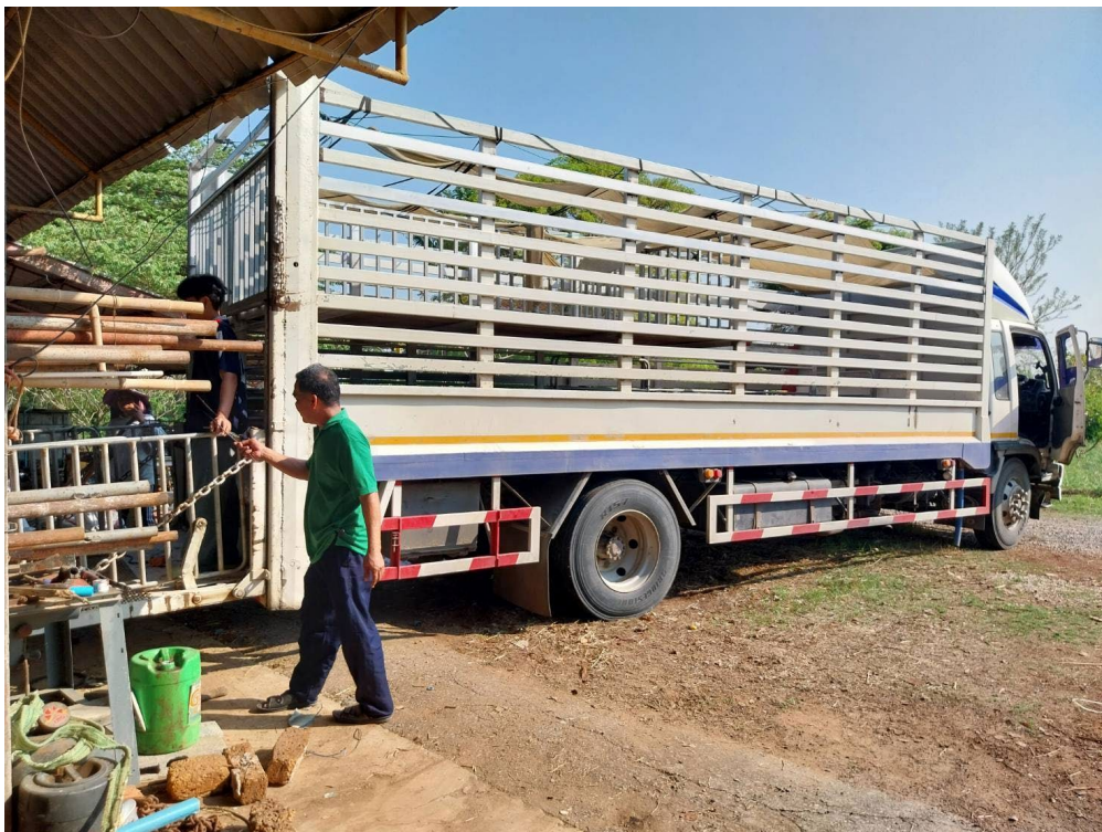
ภาพที่ ๓.๖ ขนย้ายเครื่องมือ, นั่งร้านเหล็ก เข้าพื้นที่ดำเนินงาน
