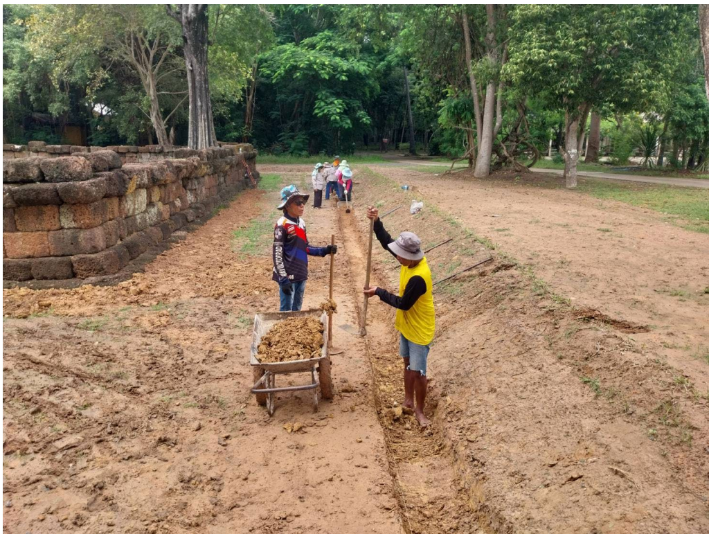
ภาพที่ ๓.๕๔ ขุดดินปรับระดับพื้นภายนอกกำแพงแก้ว และขุดรางระบายน้ำ ด้านทิศตะวันตก
