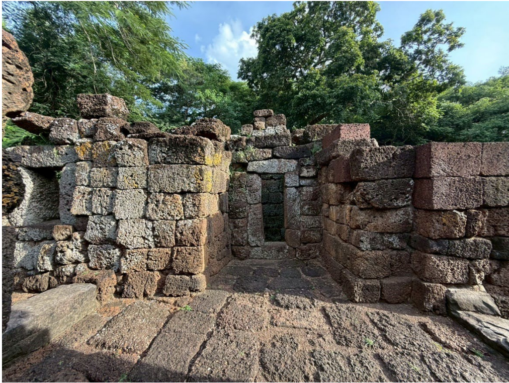
ภาพที่ ๔.๑๒ สภาพปัจจุบันห้องมุขฝังใต้ของโคปุระด้านทิศตะวันออก
