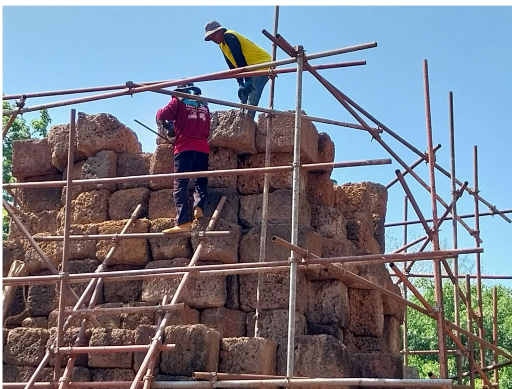
ภาพที่ ๓.๓๕ เสริมหินที่เหลือจากการทดลองประกอบชั้นสุดท้ายของชั้นวิมานชั้นที่ ๒
