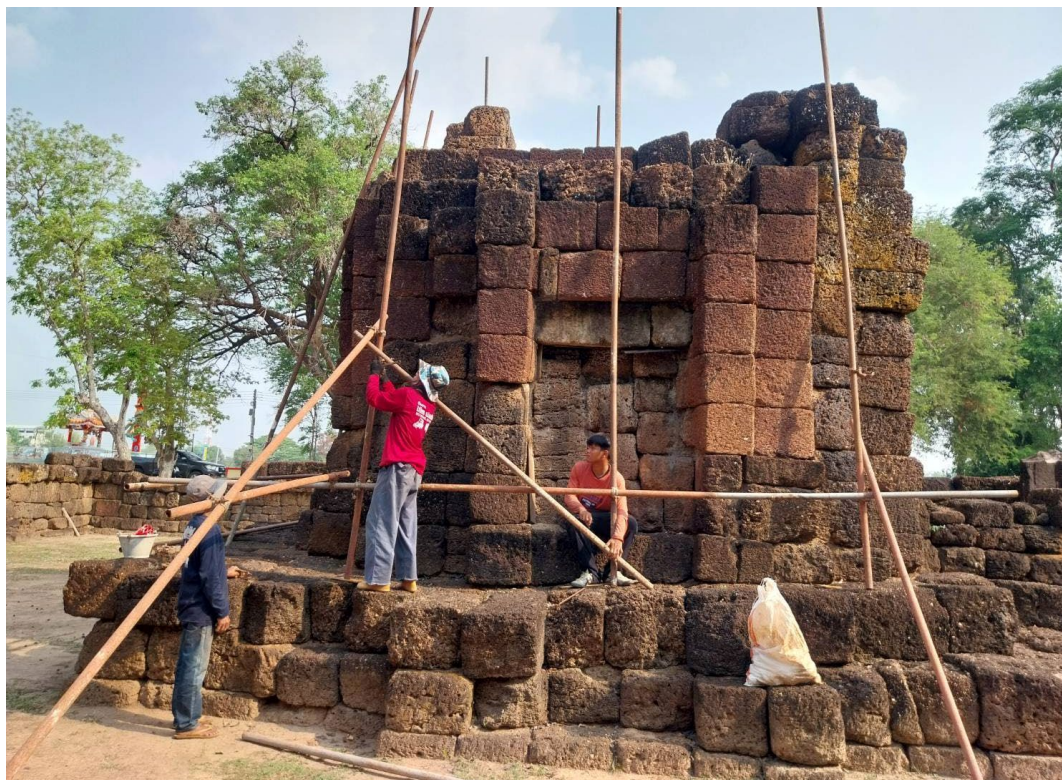
ภาพที่ ๓.๘ ตั้งนั่งร้านเหล็ก บริเวณปราสาทประธาน ด้านทิศใต้
