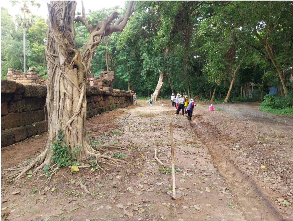
ภาพที่ ๓.๕๗ ขุดดินปรับระดับพื้นภายนอกกำแพงแก้ว และขุดรางระบายน้ำ ด้านทิศใต้
