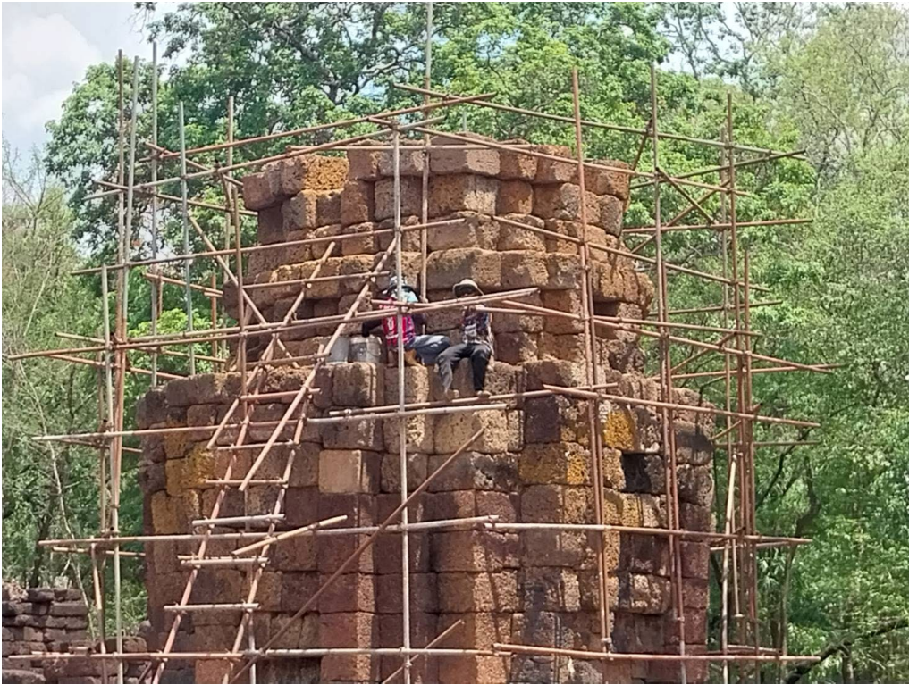
ภาพที่ ๓.๓๘ สกัต์แต่งหินที่เหลือจากการทดลองประกอบด้านทิศตะวันตก
