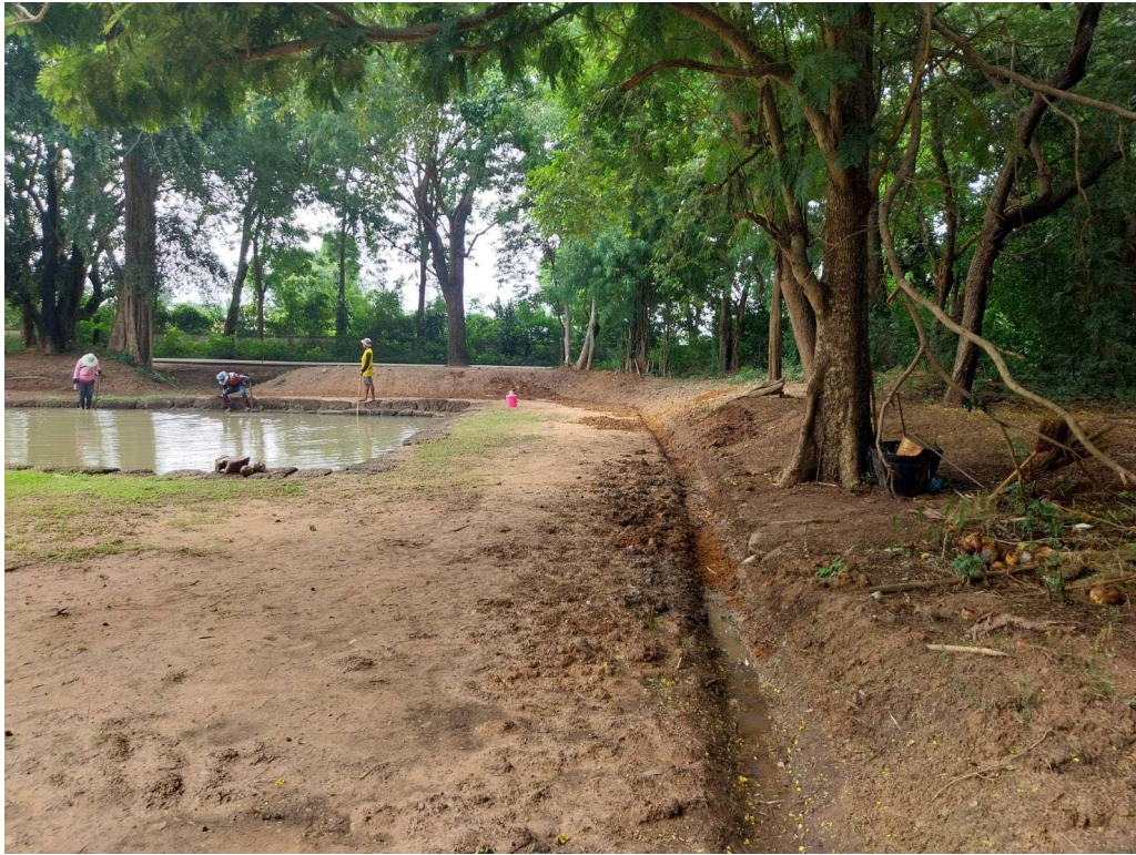
ภาพที่ ๓.๕๙ ขุดดินปรับระดับพื้นภายนอกกำแพงแก้ว และขุดรางระบายน้ำ ด้านทิศตะวันออก
