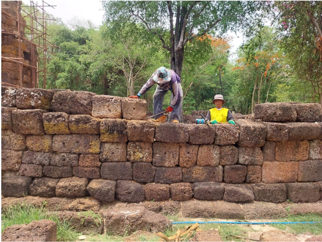
ภาพที่ ๓.๔๖ ปรับแต่งแนวหินทดลองประกอบกำแพงแก้วด้านทิศเหนือ
