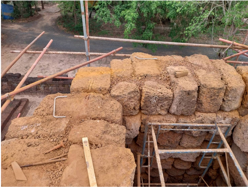
ภาพที่ ๓.๑๘ ยึดหินก้อนมุมด้วยเหล็กชุบป้องกันสนิม
