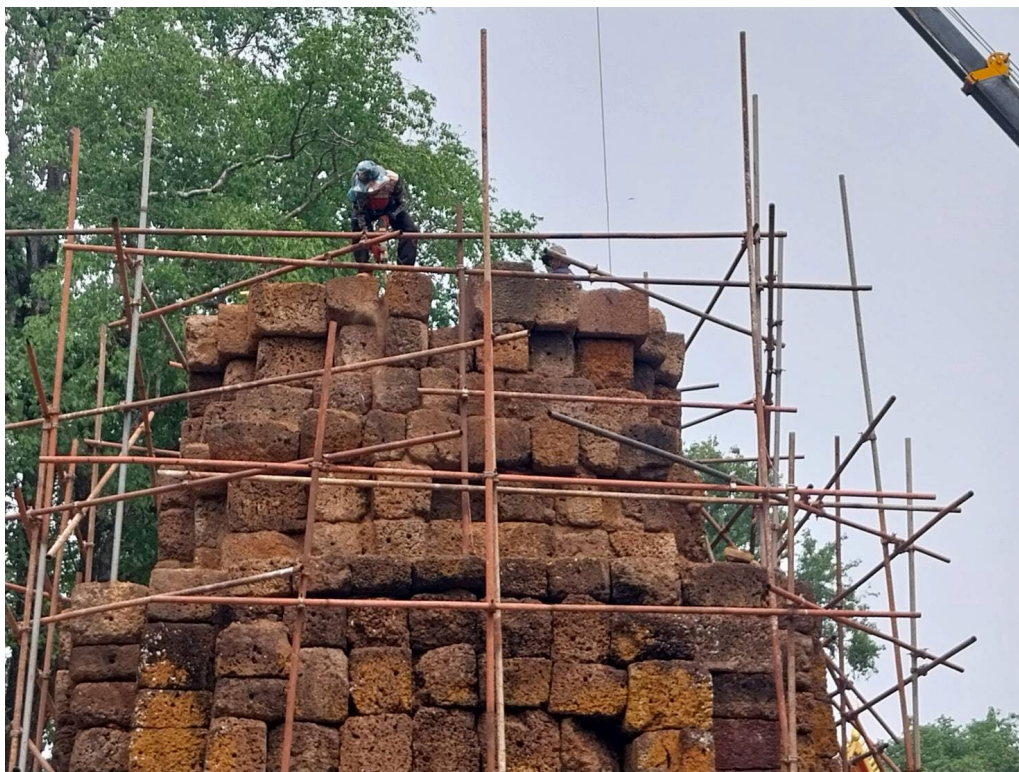
ภาพที่ ๓.๓๔ เสริมหินที่เหลือจากการทดลองประกอบชั้นสุดท้ายของชั้นวิมานชั้นที่ ๒
