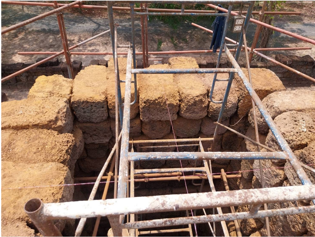
ภาพที่ ๓.๒๒ ดึงแนวกริด เก็บผังข้อมูลประกอบหินในแต่ละชั้น
