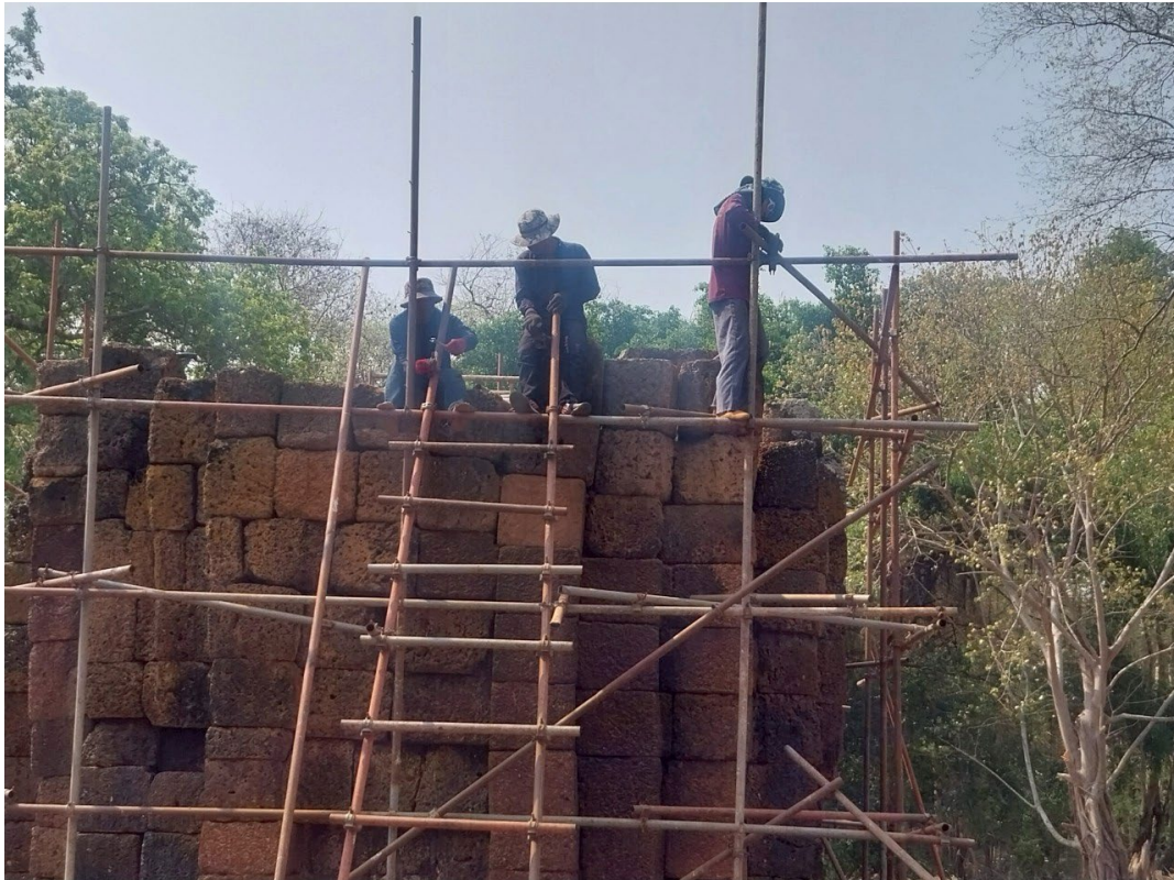
ภาพที่ ๓.๙ ดำเนินการงานเสริมหินที่เหลือจากการทดลองประกอบชั้นวิมานของปราสาทประธาน
