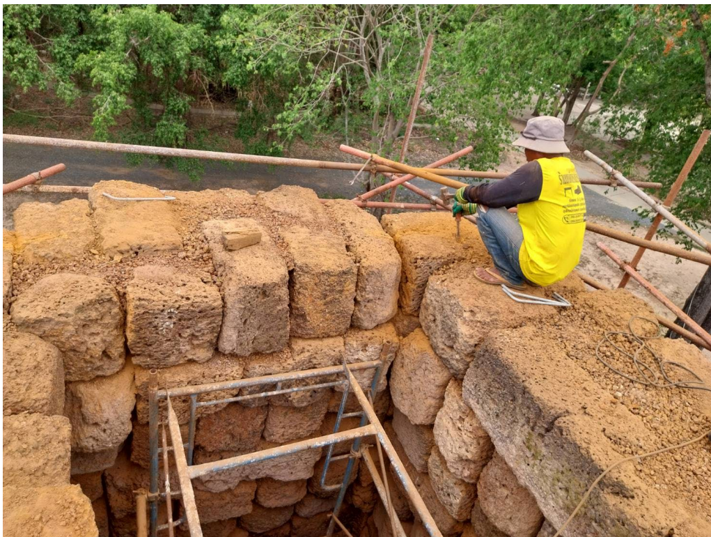
ภาพที่ ๓.๑๗ ยึดหินก้อนมุมด้วยเหล็กชุบป้องกันสนิม
