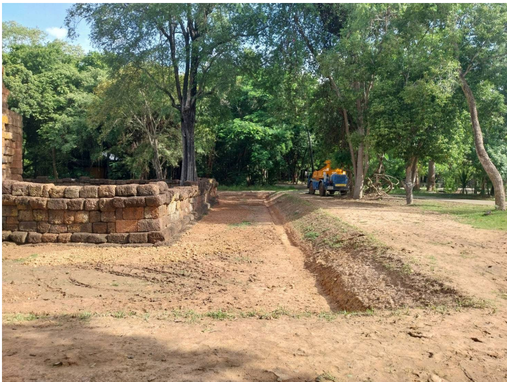
ภาพที่ ๓.๖๒ รูปด้านทิศตะวันตก หลังการดำเนินงานแล้วเสร็จ
