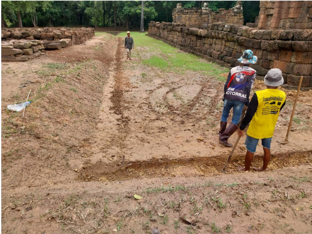
ภาพที่ ๓.๕๒ ขุดดินปรับระดับพื้นภายนอกกำแพงแก้ว และขุดรางระบายน้ำ ด้านทิศเหนือ
