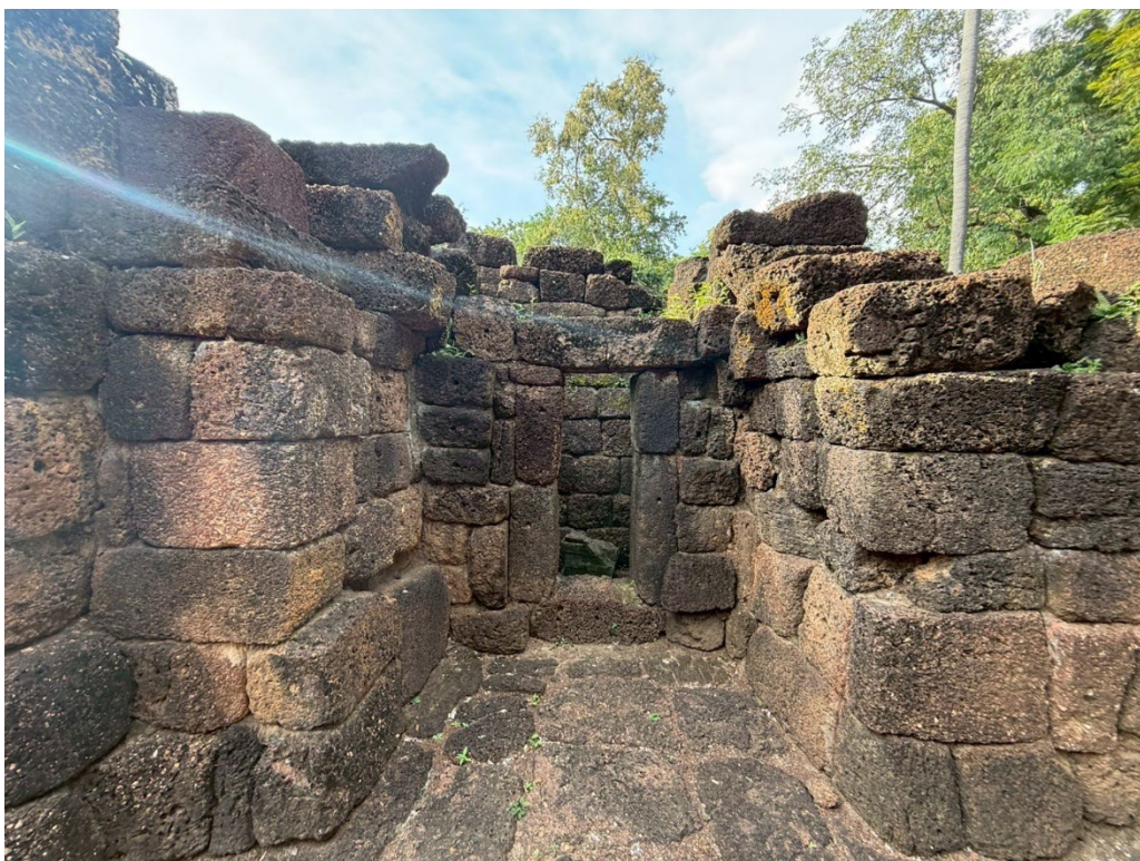
ภาพที่ ๔.๑๑ สภาพปัจจุบันห้องมุขฝั้งเหนือของโคปุระด้านทิศตะวันออก
