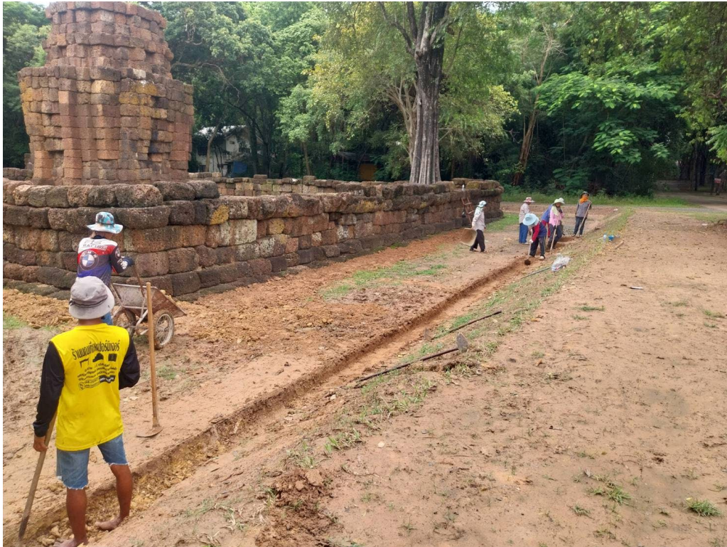
ภาพที่ ๓.๕๕ ขุดดินปรับระดับพื้นภายนอกกำแพงแก้ว และขุดรางระบายน้ำ ด้านทิศตะวันตก
