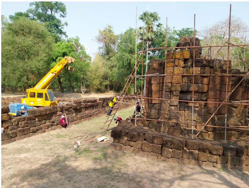
ภาพที่ ๓.๑๐ ดำเนินการงานเสริมหินที่เหลือจากการทดลองประกอบชั้นวิมานของปราสาทประธาน
