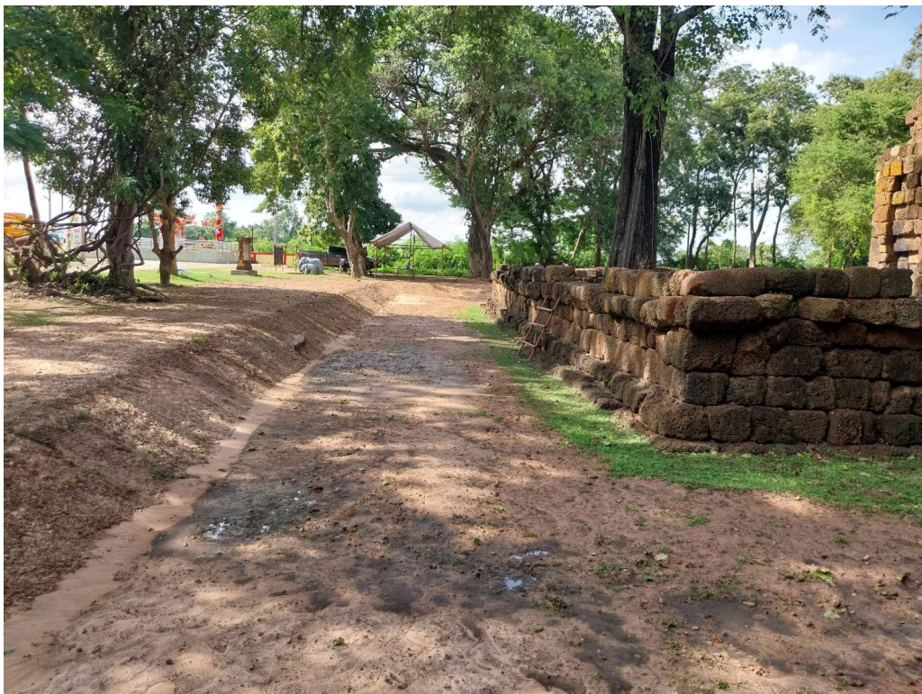
ภาพที่ ๓.๖๖ รูปด้านทิศตะวันตก หลังการดำเนินงานแล้วเสร็จ
