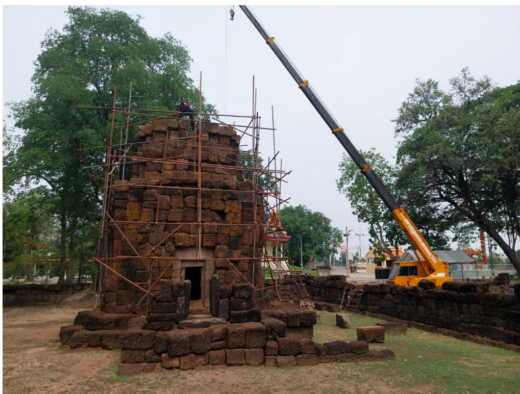
ภาพที่ ๓.๓๑ เสริมหินที่เหลือจากการทดลองประกอบชั้นสุดท้ายของชั้นวิมานชั้นที่ ๒
