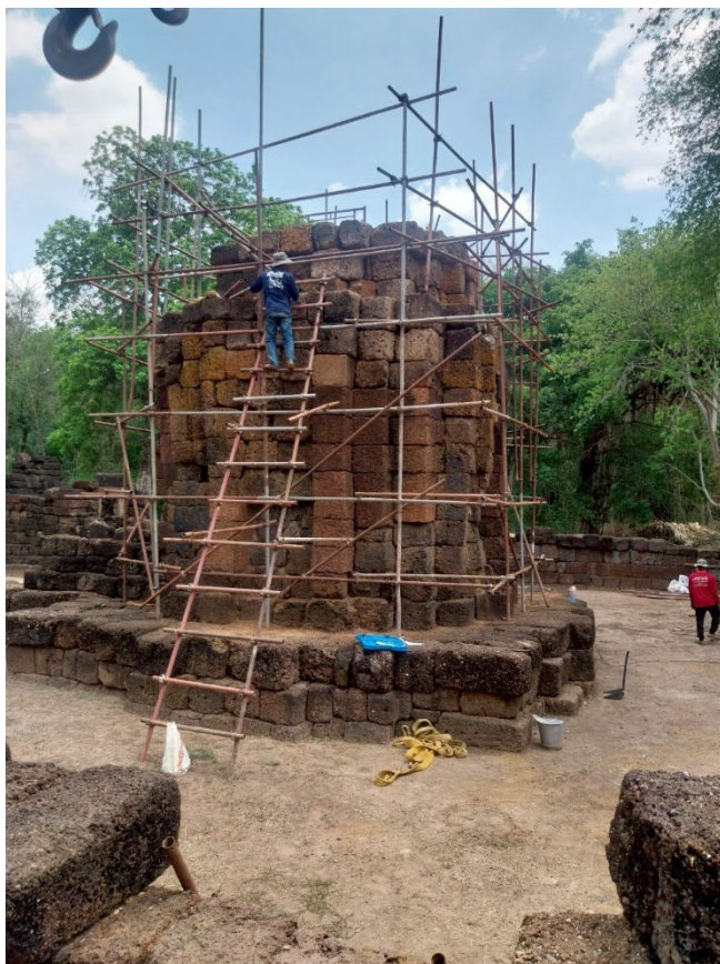
ภาพที่ ๓.๑๕ ดำเนินงานประกอบหินที่ ทดลองประกอบพร้อมเสริมหินที่เหลือจาก การทดลองประกอบ
