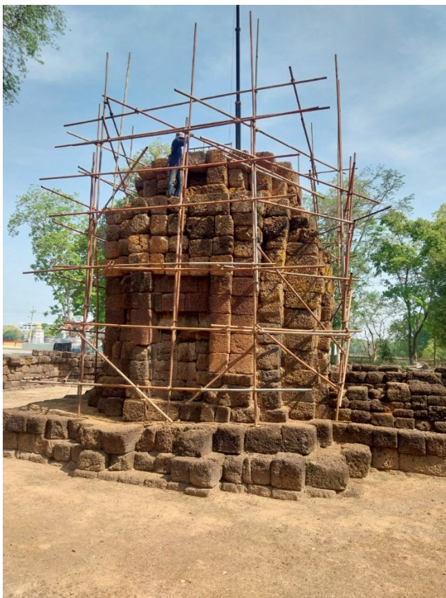
ภาพที่ ๓.๑๔ ดำเนินงานประกอบชิ้นส่วนหิน ทดลองประกอบตามผังและร่องรอยบ่หินชั้น สุดท้ายของชั้นวิมาน ปราสาทประธาน
