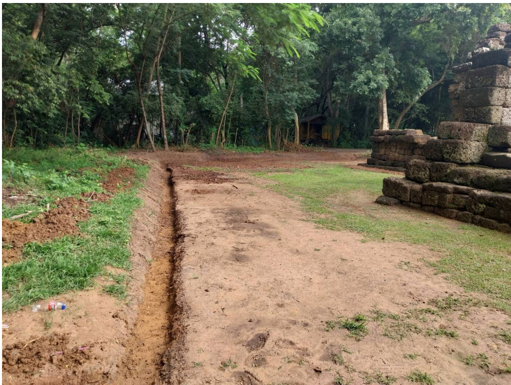
ภาพที่ ๓.๕๘ ขุดดินปรับระดับพื้นภายนอกกำแพงแก้ว และขุดรางระบายน้ำ ด้านทิศตะวันออก
