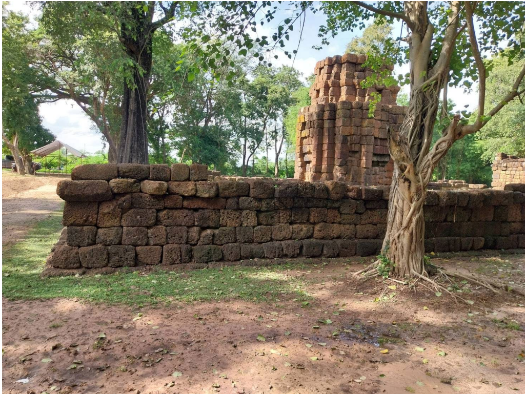
ภาพที่ ๓.๖๙ รูปด้านมุมตะวันตกเฉียงใต้ หลังการดำเนินงานแล้วเสร็จ
