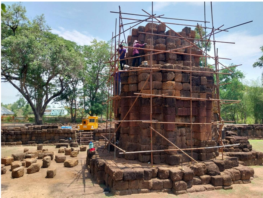
ภาพที่ ๓.๓๙ สกัต์แต่งหินที่เหลือจากการทดลองประกอบด้านทิศใต้
