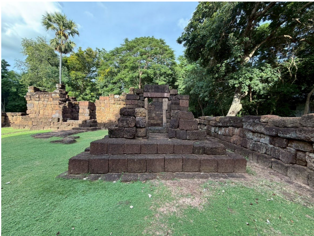
ภาพที่ ๔.๕ สภาพปัจจุบันบรณาลัยด้านทิศตะวันตก
