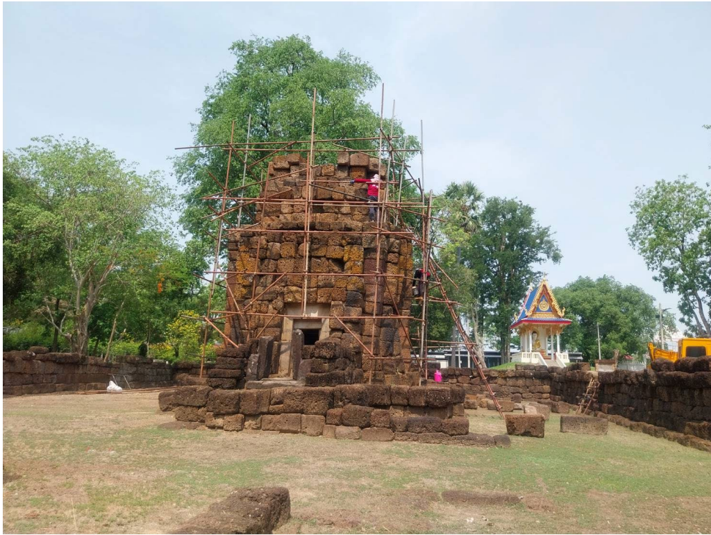
ภาพที่ ๓.๔๐ สกัต์แต่งหินที่เหลือจากการทดลองประกอบด้านทิศตะวันออก
