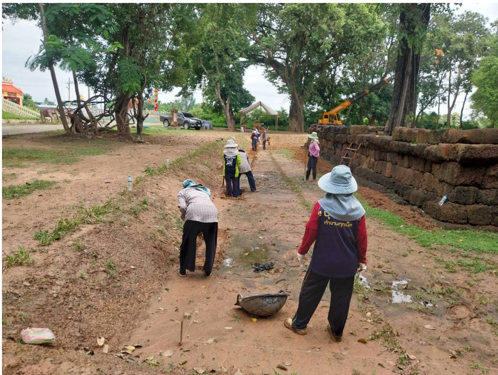
ภาพที่ ๓.๕๖ ขุดดินปรับระดับพื้นภายนอกกำแพงแก้ว และขุดรางระบายน้ำ ด้านทิศตะวันตก
