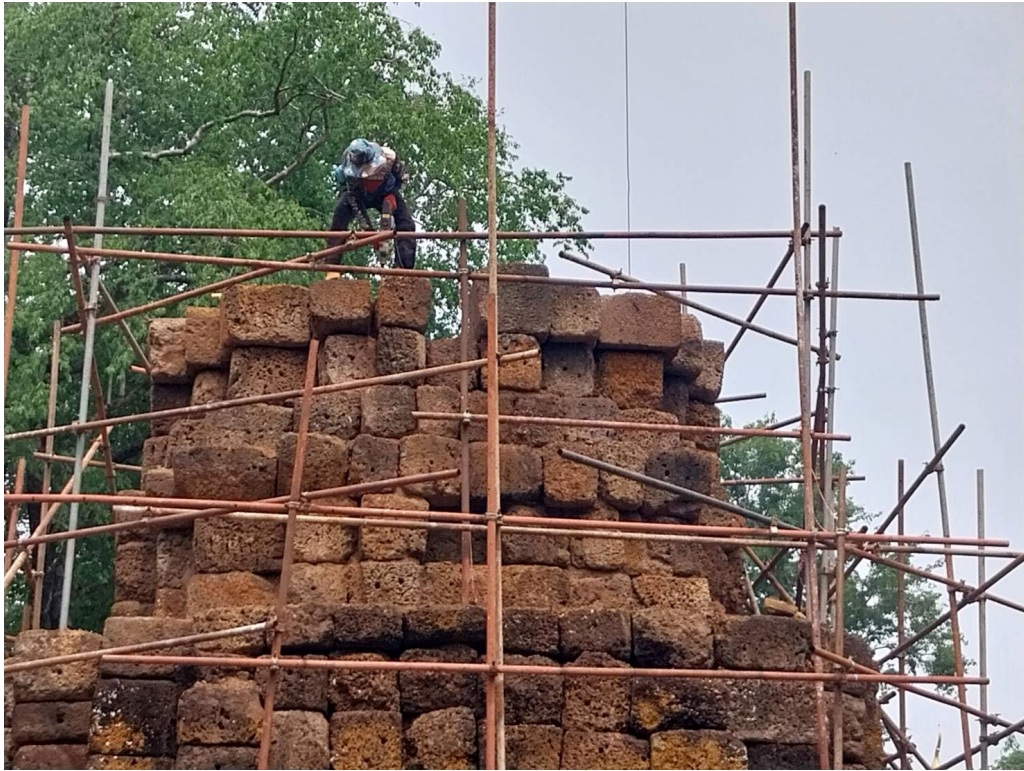
ภาพที่ ๓.๓๒ เสริมหินที่เหลือจากการทดลองประกอบชั้นสุดท้ายของชั้นวิมานชั้นที่ ๒
