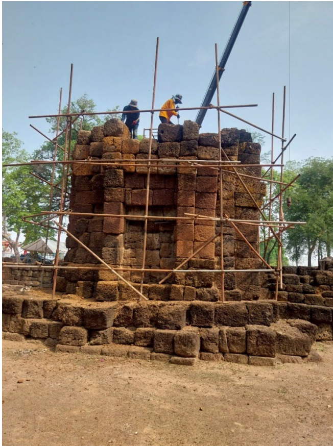
ภาพที่ ๓.๑๑ ดำเนินการงานเสริมหินที่เหลือ จากการทดลองประกอบชั้นวิมานของปราสาท ประธาน
