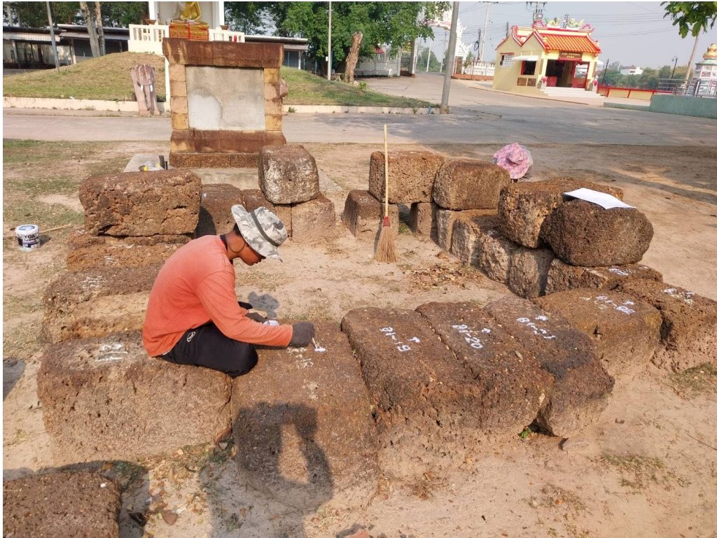
ภาพที่ ๓.๒๔ ทำผังรื้อหินที่ทดลองประกอบก่อนนำกลับมาเรียง ชั้นวิมานชั้นที่ ๒
