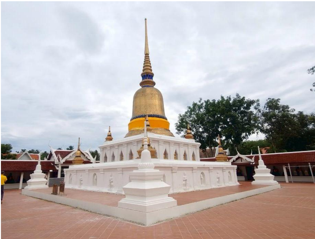
พระบรมธาตุสุวี สภาก่อหลังการบูรณะพ.ศ.๒๕๖๗
