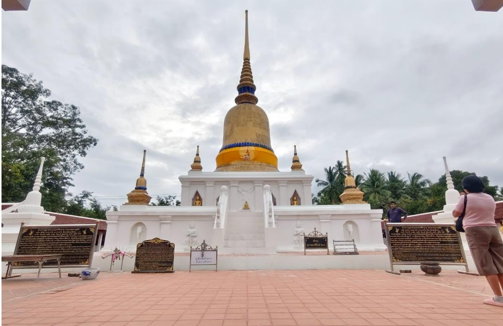
พระบรมธาตุสุวี สภาก่อหลังการบูรณะพ.ศ.๒๕๖๗
