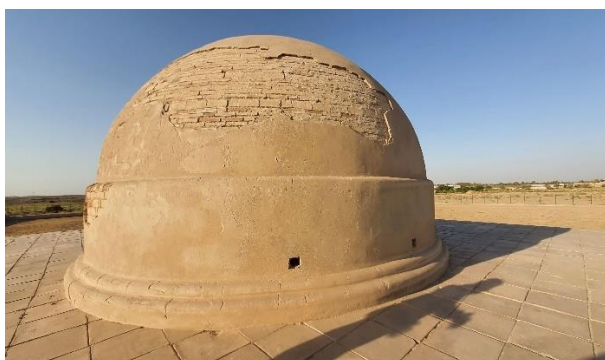
สถูปภายนอกก่อสร้างด้วยอิฐดิบ และฉาบด้วยดิน
