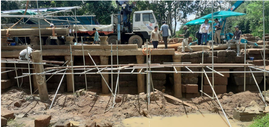
การบูรณะสะพานนาคราชด้านทิศตะวันออกของปราสาทบึงมาลา
