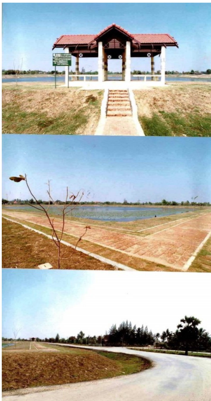
ภาพที่ 2-4 การดำเนินงานสระเพลง ปีงบประมาณ 2533
