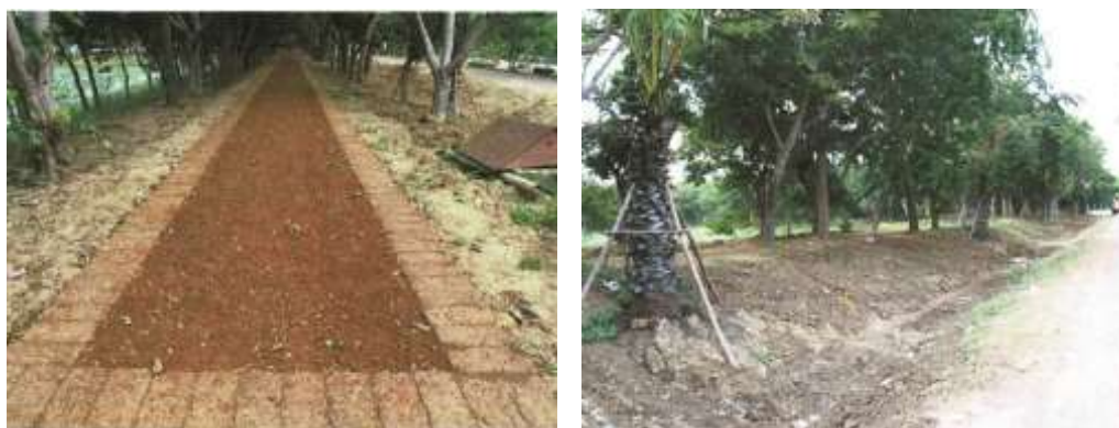
ภาพที่ 7-8 การดำเนินงานสระเพลง ปีงบประมาณ 2561
