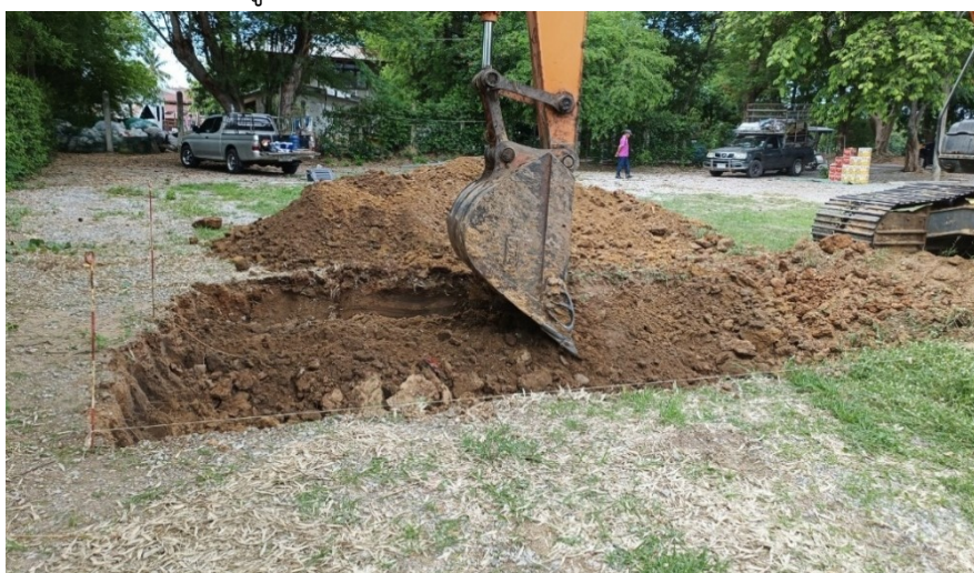
ภาพที่ 11 เทคนิคการขุดตรวจโดยใช้รถขุดครั้งละ 20 เซนติเมตร
