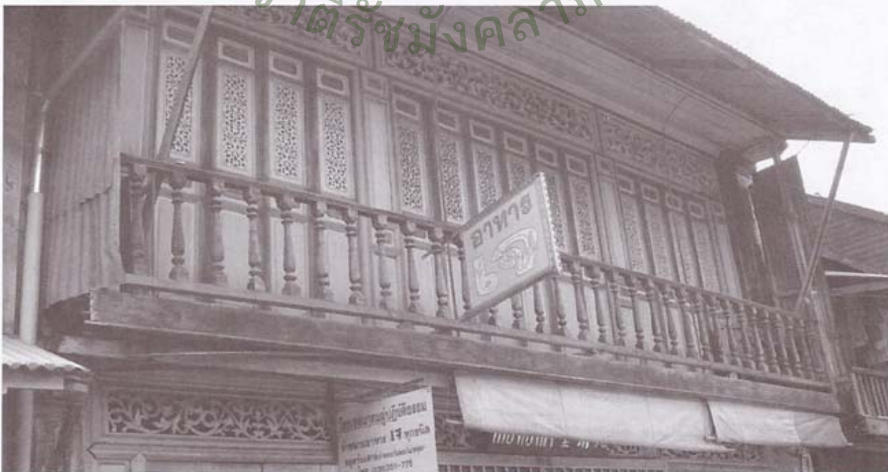
▲ อาคารที่มีลักษณะแบบเรือนแถว บริเวณท่าหลวง
