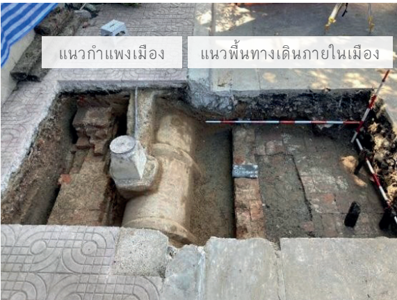
แนวกำแพงเมืองที่ได้จากการขุดค้นบริเวณพื้นที่ก่อสร้างรถไฟฟ้าใต้ดินสายสีม่วง สถานีสามยอด
