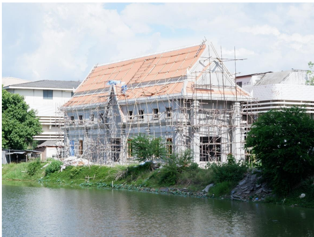
ภาพที่ 2.38 สถานพระนารายณ์หลังใหม่อยู่ระหว่างก่อสร้าง
