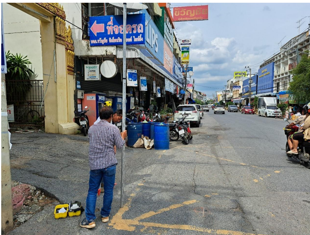
ภาพที่ 3.9 ส่องกล้องระดับเพื่อค่าระดับอ้างอิงมาตรฐานของหลุมชุดคันเปรียบเทียบกับค่าระดับอ้างอิงมาตรฐานของแหล่งกับหลุมชุดคันทั้ง 5 หลุม
