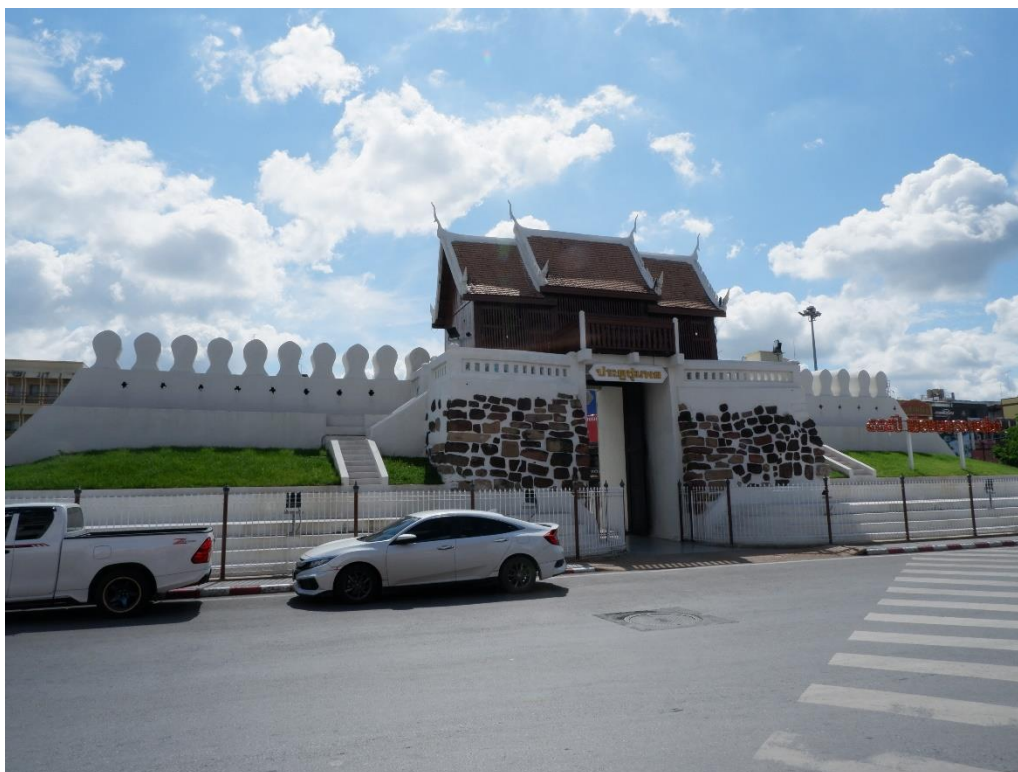
ภาพที่ 2.2 สภาพปัจจุบันประตูชุมพล ตั้งอยู่ทางด้านทิศตะวันตกของถนนชุมพล
