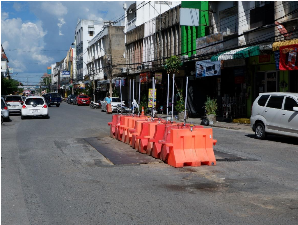
ภาพที่ 3.4 ตำแหน่งหลุมขุดคันที่ 1 (M.H.1)
