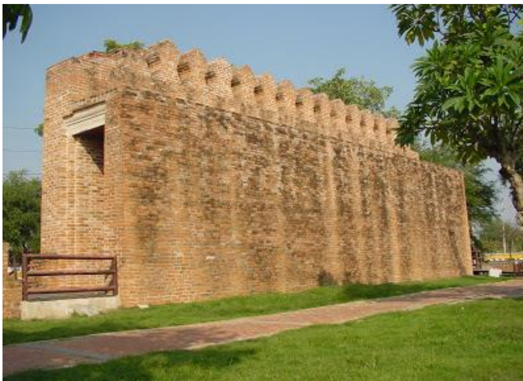
ภาพที่ 1.12 สภาพปัจจุบัน แนวกำแพงเมืองนครราชสีมาจำลอง ด้านทิศตะวันออกเฉียงเหนือ
