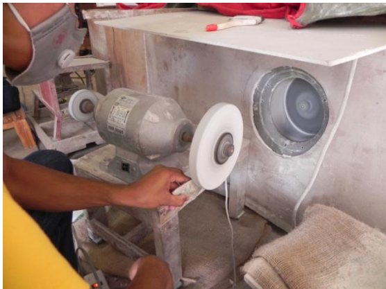
พัดลมดูดอากาศ
