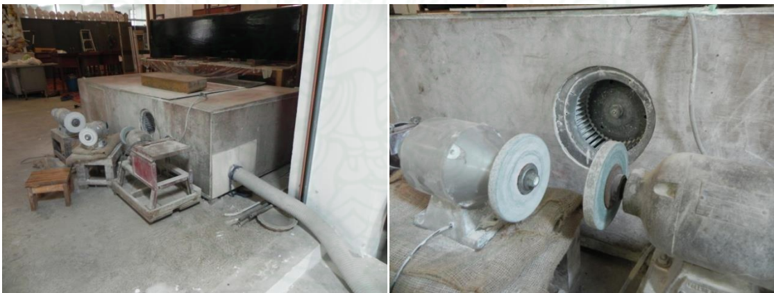
ทำตู้ดูดเก็บฝุ่นขณะปฏิบัติงานขัด ตัด เจียรเปลือกหอย
