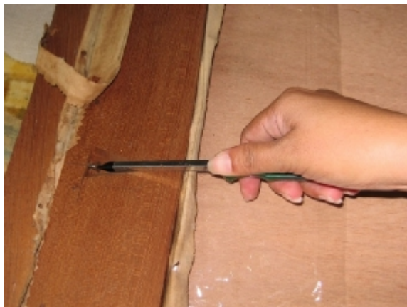
ตะปูเกลียวใช้เป็นตัวยึดเฟรม 2 เฟรมติดกัน
