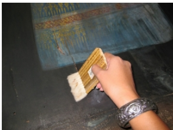
การทำทำความสะอาดโดยใช้แปรงขนกระต่ายปิดฝุ่นออก
